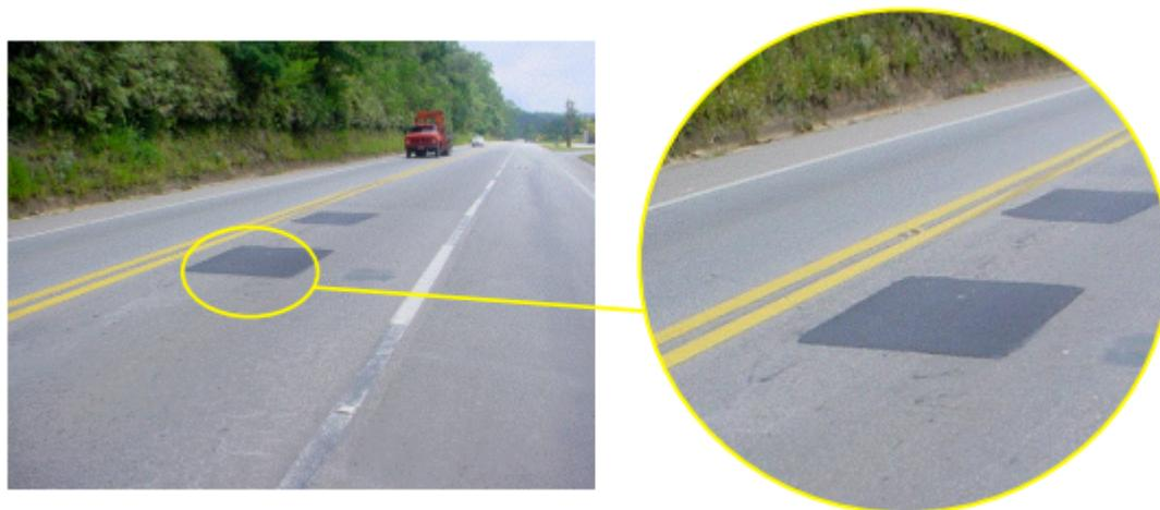
*Figura 14 – Remendos (Fonte: IP-DE-P00/004)*
