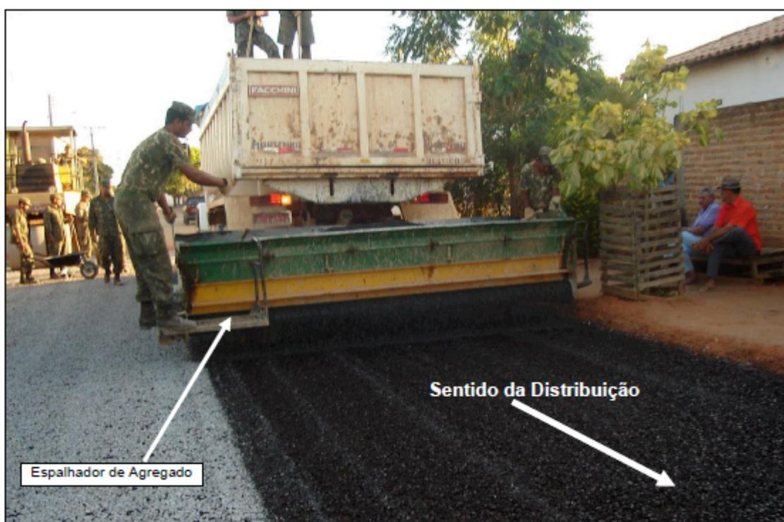
Figura 39 – Distribuição de agregado
