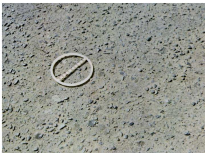
*Figura 12 – Desgaste (Fonte: DNIT, 2003)*
