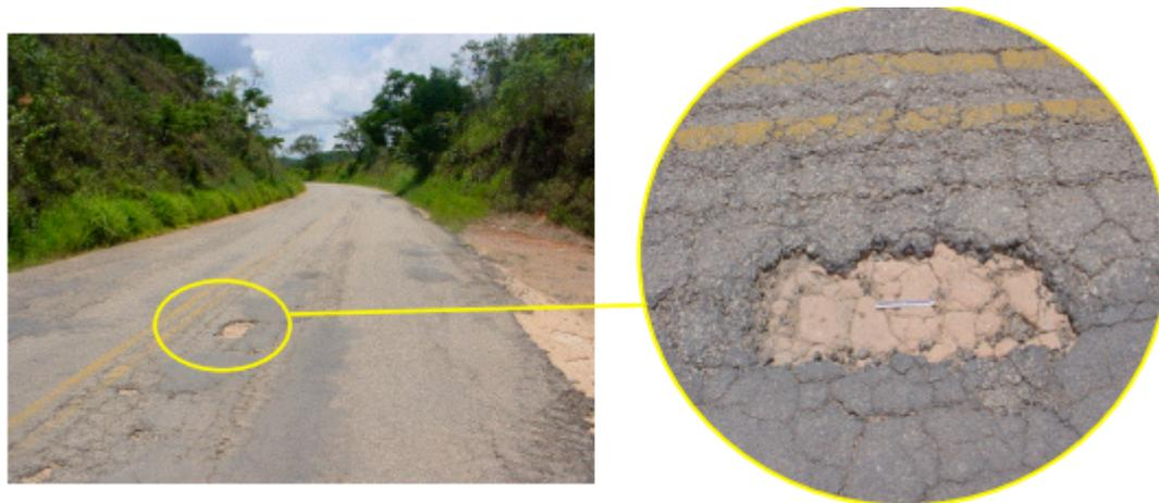
*Figura 13 - Panela ou Buraco (Fonte: IP-DE-P00/004)*
