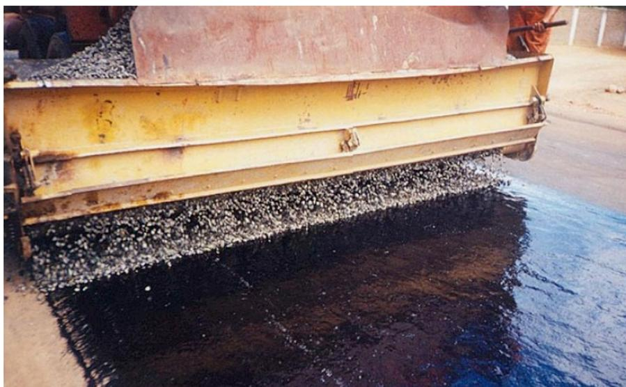
Figura 31 – Despejo de agregados sobre o ligante
