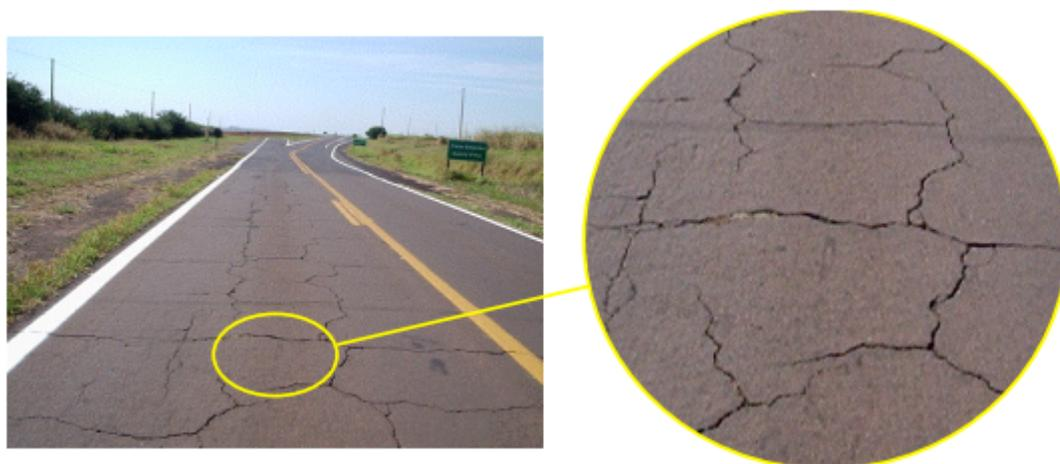
*Figura 8 - Trinca Interligada (Fonte: IP-DE-P00/004)*
