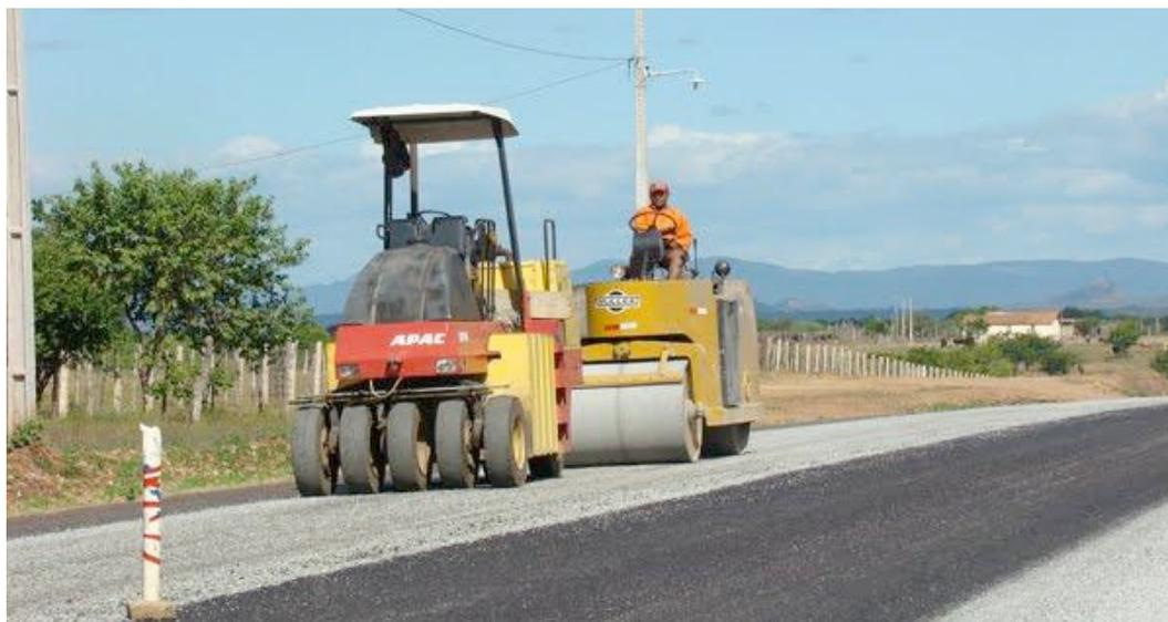
Figura 40 – Rolos Compressores de Pneus e Liso
