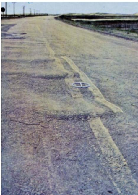
*Figura 9 - Ondulações ou corrugações (Fonte: DNIT, 2003)*
