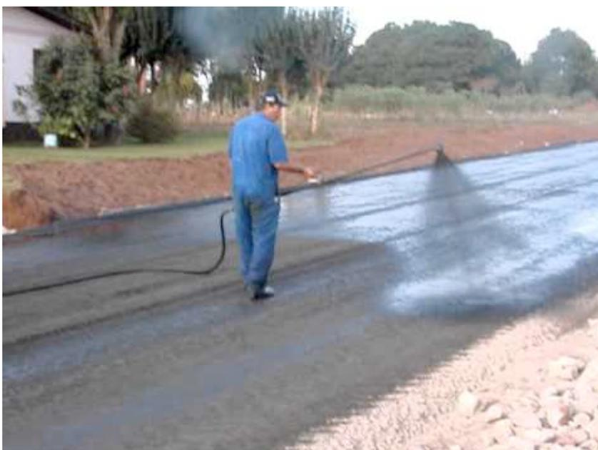
Figura 35 – Correção de falhas na aplicação com caneta distribuidora
