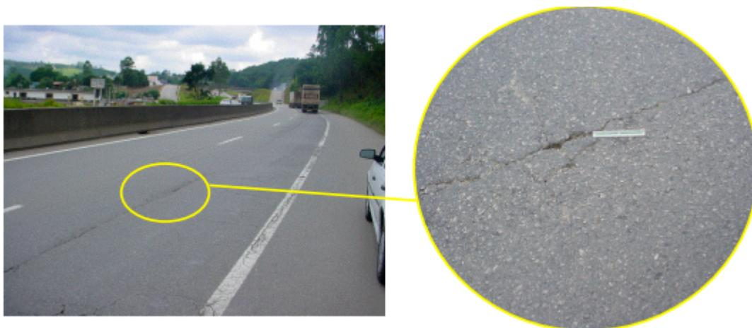
Figura 7 - Trinca isolada (Fonte: IP-DE-P00/004)
