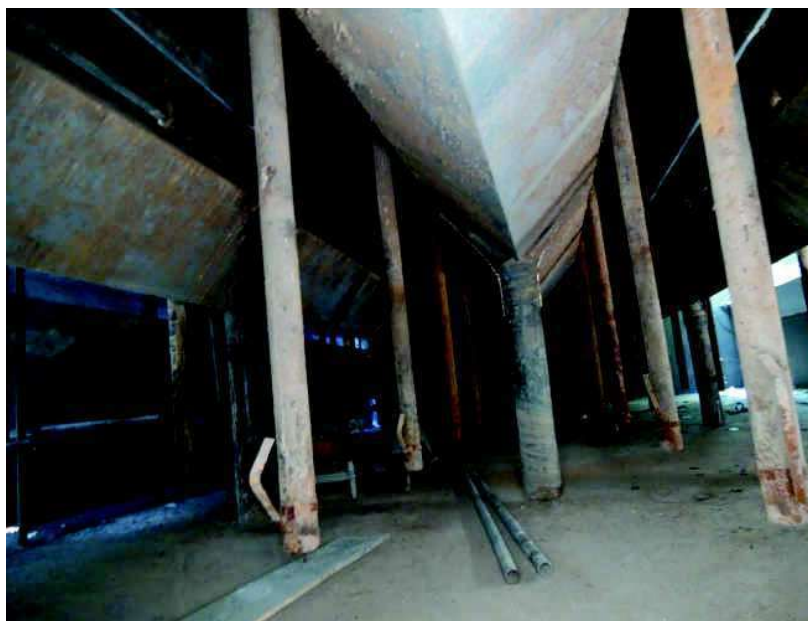
Figura 9: Estrutura interna de uma RAFA
