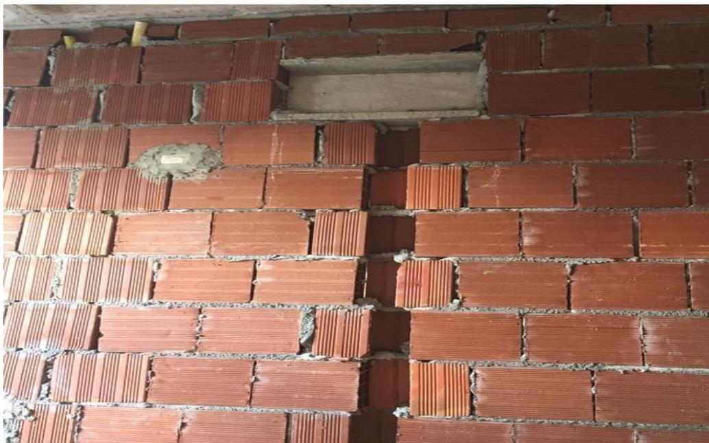
**Figura 20** – Parede de alvenaria com furo de espera para o dreno
