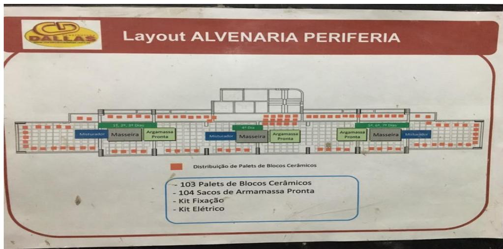
**Figura 9** – Layout da distribuição dos materiais para alvenaria no pavimento
