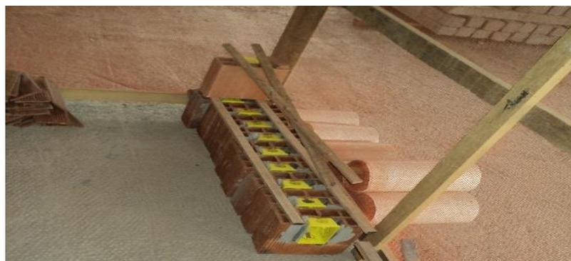
**Figura 19** – Blocos cerâmicos com caixas de elétrica chumbadas
