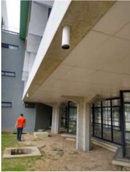
Figura B5 – Tubulação / Caixa de Brita
