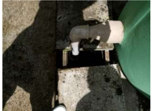
Figura B10 – Conexão Reservatório – Câmara de Carga
