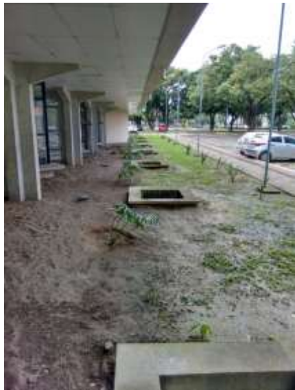
Figura B7 – Sequência de Poços Absorventes
