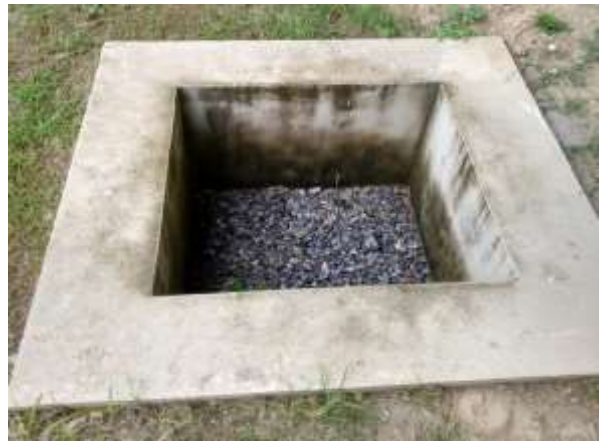
Figura B6 – Poço Absorvente
