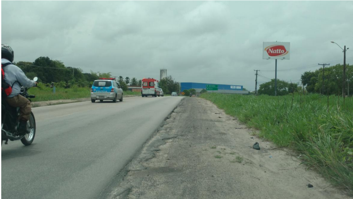
Figura 4 - Grande Reparo, Km 57 da BR-101 (Fonte: Borba, Guilherme C. L.)
