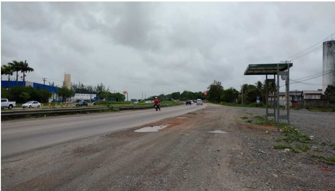
Figura 13 - Ausência de sinalização vertical no trecho. (Fonte: Borba, Guilherme C. L.)
