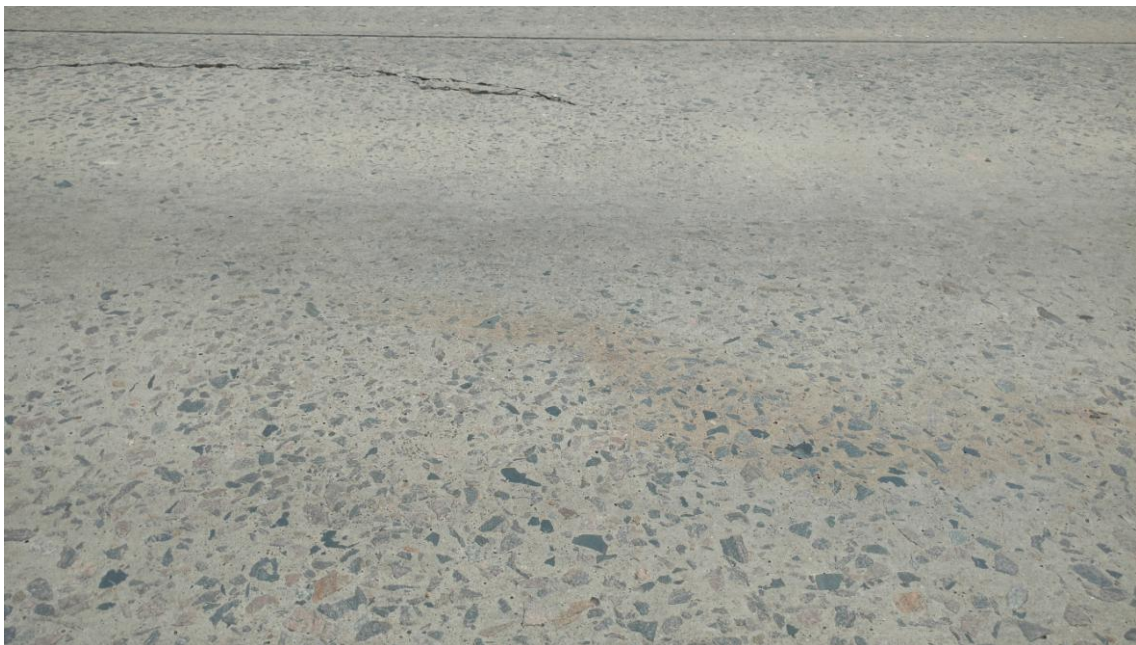
Figura 9 - Desgaste superficial. (Fonte: Borba, Guilherme C. L.)
