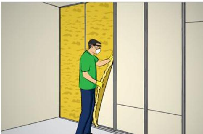
Figura 6. Isolamento lã de vidro ou lã mineral
