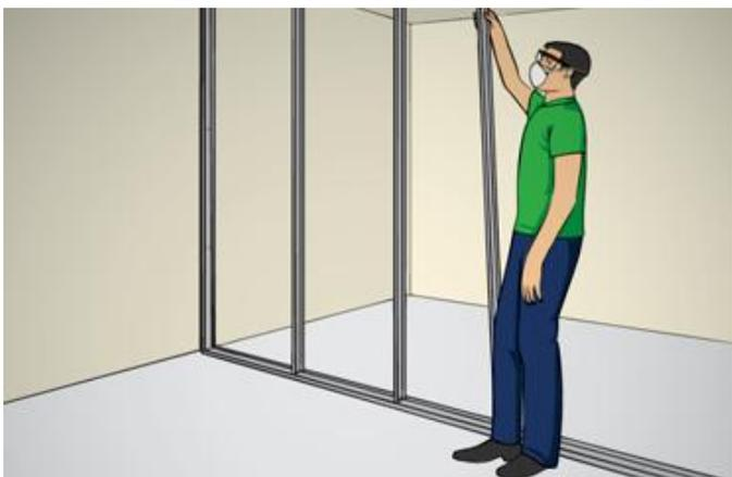
Figura 5. Instalações dos montantes
