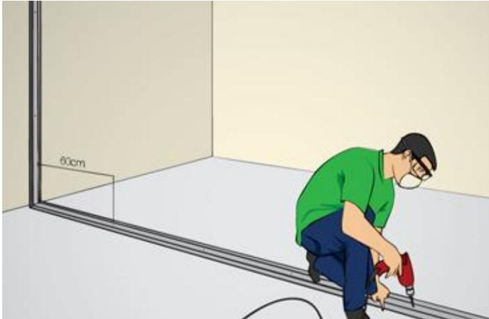
Figura 4. Marcação e fixação das guias
