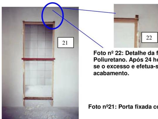
Foto nº 22: Detalhe da fixação com Poliuretano. Após 24 horas corta-se o excesso e efetua-se o acabamento.
