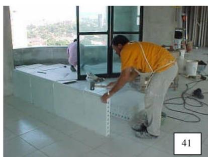
Continue a montagem da divisória SISTEMA CONSTRUTIVO GYPWAY, sempre aplicando GESSO COLA GYPWAY na parte que será colada no piso e no BLOCO DE GESSO GYPWAY.
