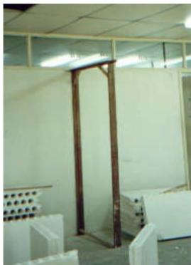
Foto nº23: Colocação da grade de porta para iniciar o assentamento da divisória NO SISTEMA CONSTRUTIVO GYPWAY
