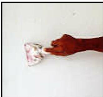
Em qualquer caso, antes da aplicação da MASSA PARA ACABAMENTO GYPWAY, limpe previamente a superfície eliminando as partes soltas (usando o desempeno de aço), as manchas gordurosas (lavando com água e sabão ou detergente), o mofo (com uma solução de água sanitária e água na proporção 1:1) e a poeira.
