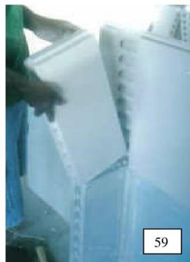
Continue a montagem da divisória NO SISTEMA CONSTRUTIVO GYPWAY alternando as fileiras, ou seja, em uma fileira a colagem dos BLOCOS DE GESSO será encostando-os a superfície e a seguinte a colagem será no entalhe do BLOCO DE GESSO GYPWAY (fotos n.º 58 e 59) .
