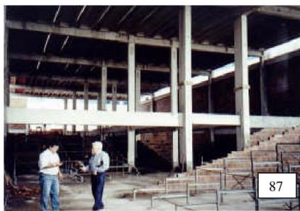
Foto n.º 87– Área em que será necessária a utilização de estruturas auxiliares para a utilização do SISTEMA NO SISTEMA CONSTRUTIVO GYPWAY
