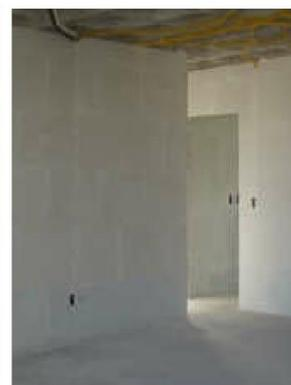
Ao lado parede com o cortes para colocação de eletrodutos e depois já com o acabamento efetuado
