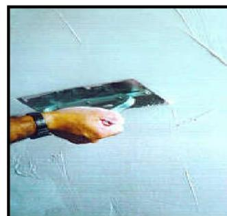
b) Assim que a primeira camada perder o brilho superficial, aplica-se a Segunda camada, procurando corrigir toda a superfície e deixando a parede em condições de lixamento.
