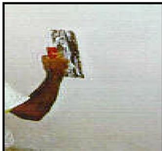
a) Com o auxílio do desempeno de aço inoxidável, espalhar a primeira camada da MASSA PARA ACABAMENTO GYPWAY, procurando cobrir toda a superfície.
