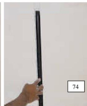
Colocação das tubulações no corte efetuado na divisória do SISTEMA CONSTRUTIVO GYPWAY (foto n.º 74).
