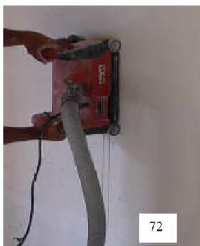
Corte dos BLOCOS DE GESSO com máquina de sulcos, deixando uma folga de 4 mm para o acabamento (foto nº 72).
