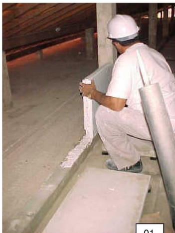
Se o solo é irregular demais ou é constituído por um piso antigo irregular, será necessário realizar uma base em concreto ou argamassa com largura correspondente à espessura do BLOCO DE GESSO GYPWAY utilizado (Foto nº 01).
