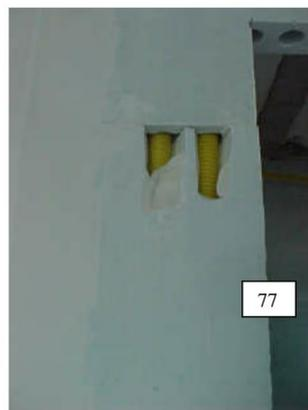
Os cortes efetuados, para auxiliar a passagem das tubulações, ou para colocação das caixas devem ser arrematadas com **GESSO COLA GYPWAY**.
