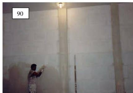
Foto n.º 81 – Divisória NO SISTEMA CONSTRUTIVO GYPWAY onde foi utilizado Pilares em BLOCO DE GESSO GYPWAY/COLA DE GESSO como estrutura de apoio.
