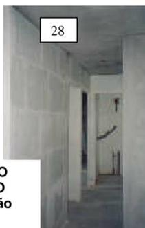
Foto n.º 28 – Divisória NO SISTEMA CONSTRUTIVO GYPWAY antes da fixação da grade de porta com poliuretano.
