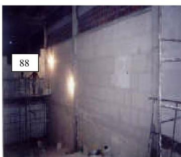
Foto n.º 88– Divisória NO SISTEMA CONSTRUTIVO GYPWAY onde foi utilizado estrutura metálica, isto devido a altura e distância das paredes superarem a tolerância máxima
