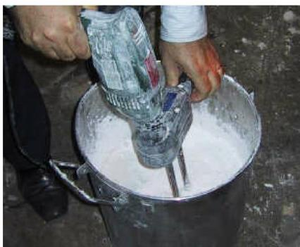
Preparação da MASSA PARA ACABAMENTO GYPWAY utilizando-se um misturador
