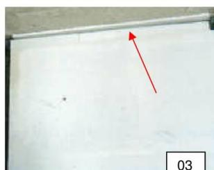
O espaço entre a faixa resiliente e o alto da divisória do SISTEMA CONSTRUTIVO GYPWAY (foto nº 03) deverá ser preenchido por uma mistura constituída por 50% de cola branca e 50% de GESSO COLA GYPWAY.
