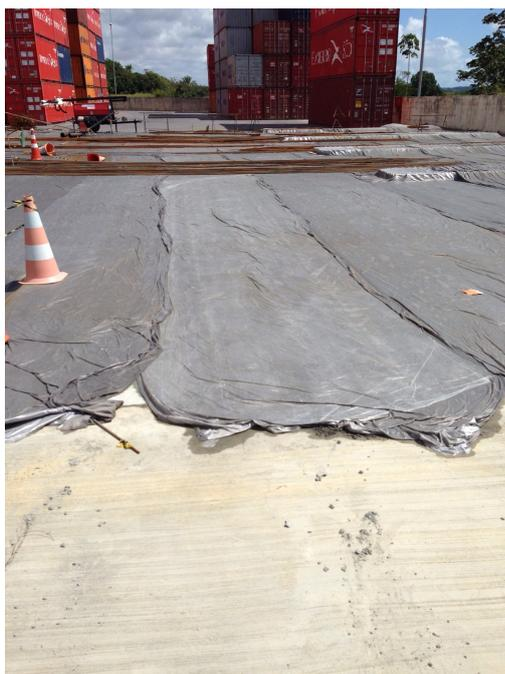
Figura 13 - Laje em processo de cura
