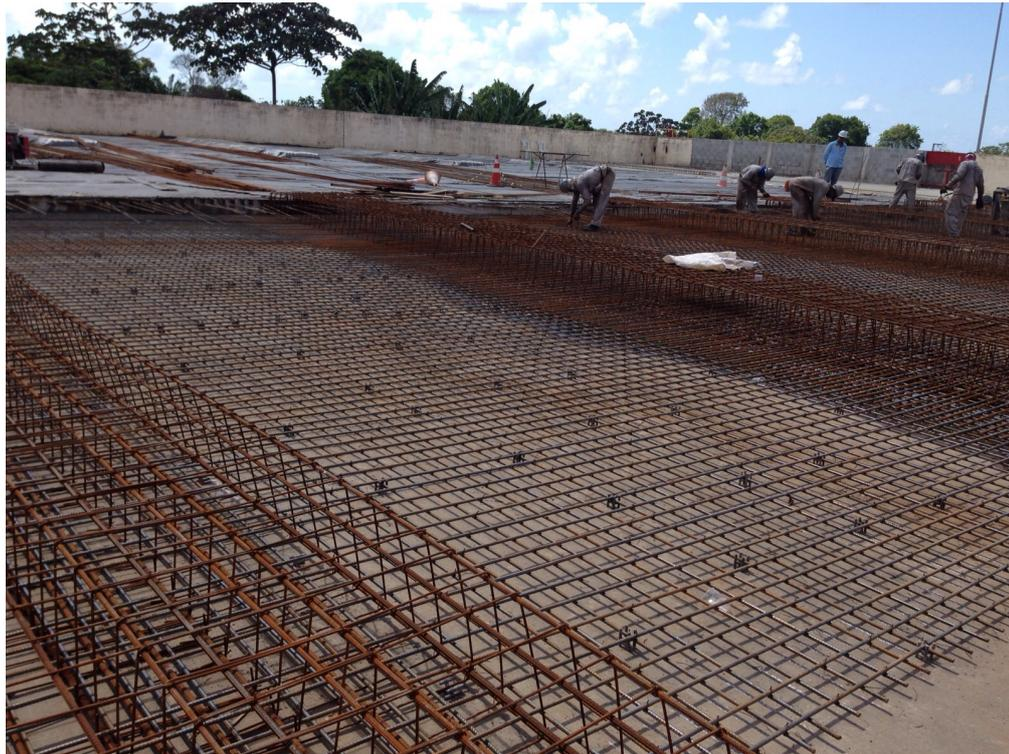
Figura 37 - Disposição das armaduras da laje e das vigas, em obra
