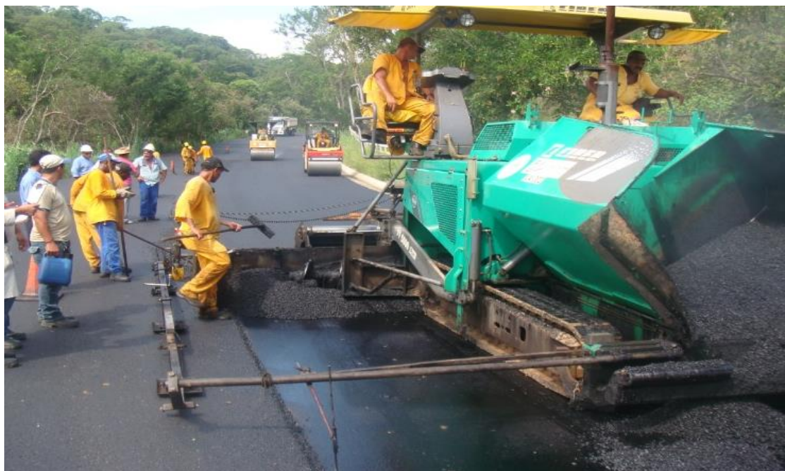
Figura 17 – Aplicação do asfalto - borracha
