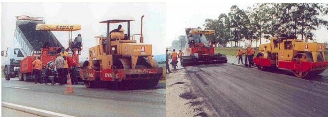
Figura 18 – Compactação do asfalto – borracha
