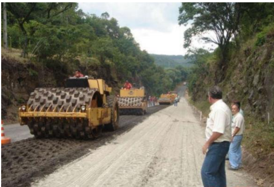
Figura 7 – Rolo compactador tipo “pé de carneiro”
