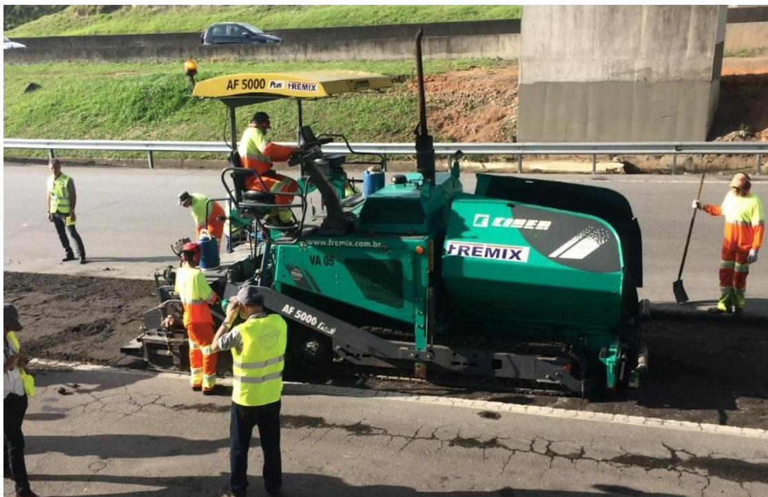
Figura 12 – Aplicação da vibroacabadora.
