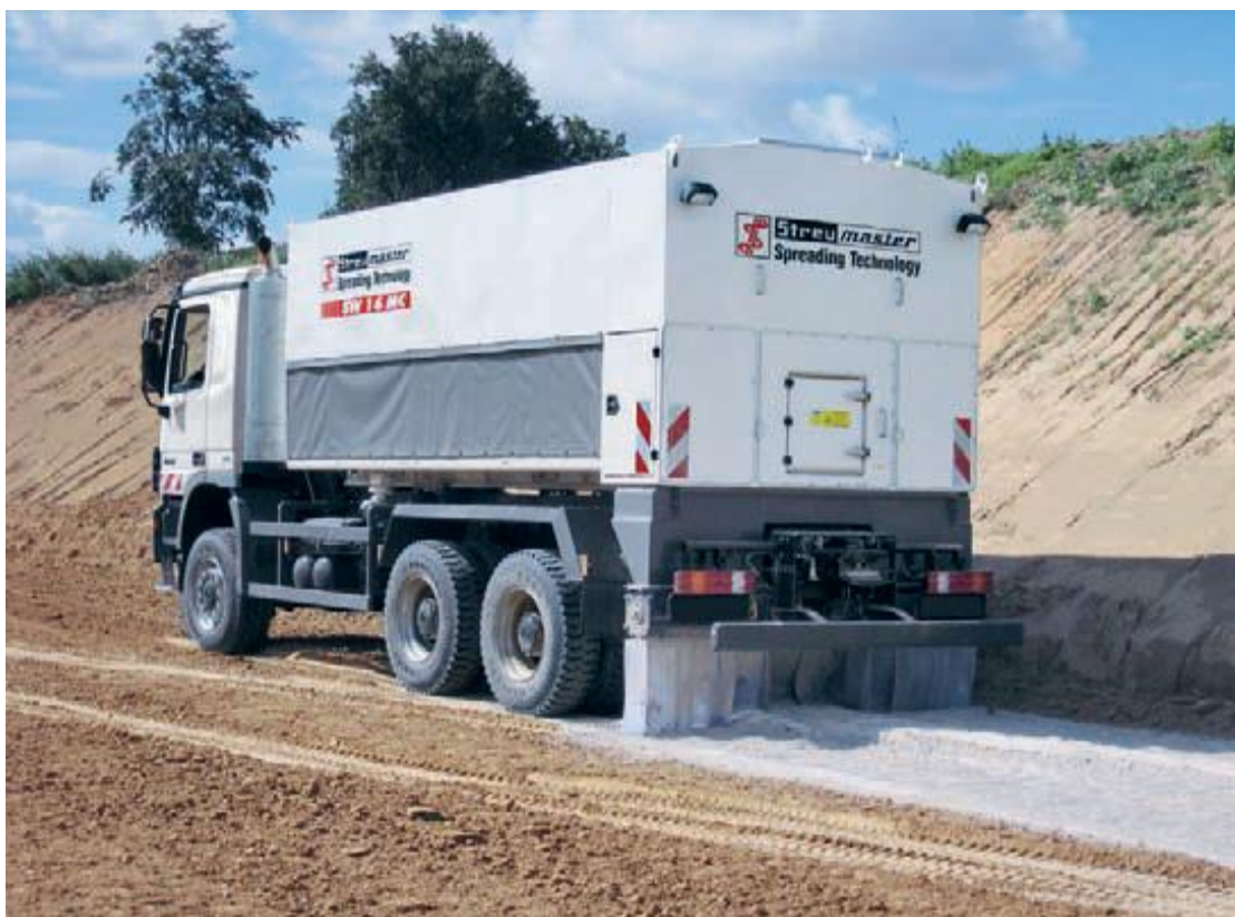
Figura 6 – Espargido de cimento para reciclagem
