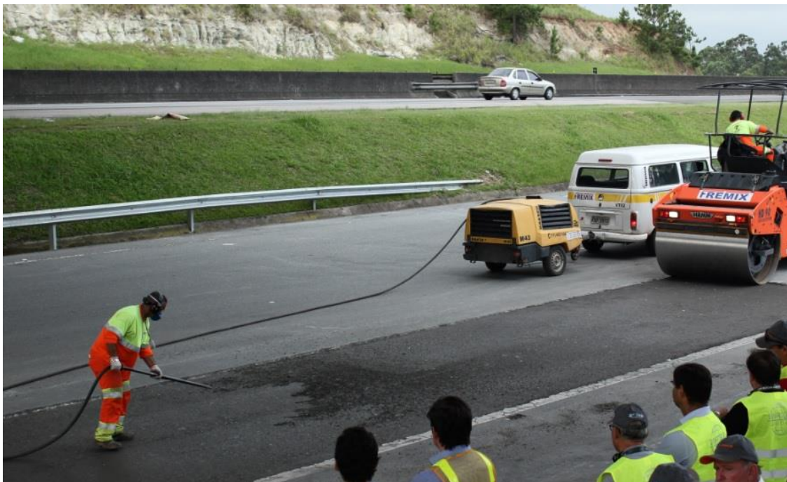
Figura 10 –Jateamento de ar para remoção de partículas.
