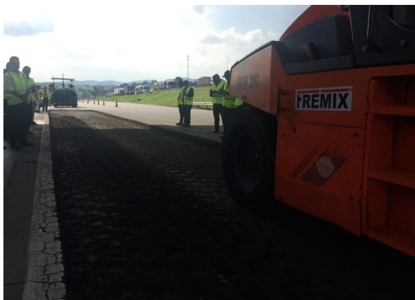
Figura 9 – Rolo pneumático compactando a reciclagem asfáltica.
