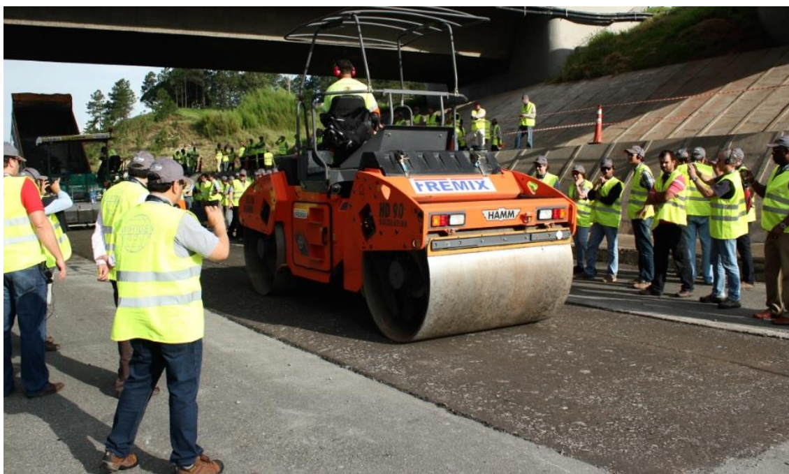
Figura 15 – Rolo tandem dando o selamento ao BSM.
