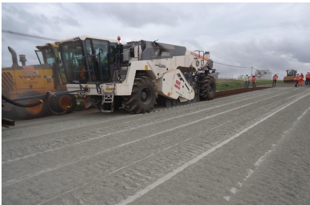
Figura 1 – Recicladora com adição de cimento
