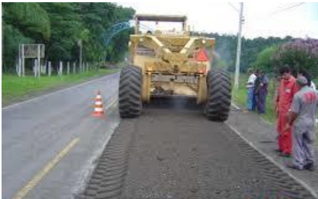
Figura 8 – Motoniveladora regularizando o nível do material reciclado.
