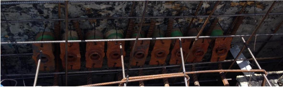
*Figura 23 - Posicionamento das formas para nicho na forma de bordo.*
