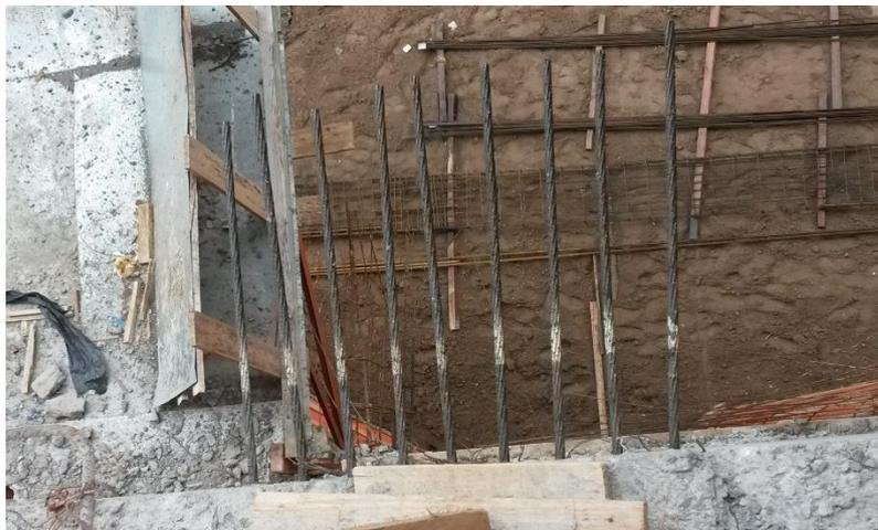
*Figura 28 - Cordoalhas marcadas com spray, para permitir a medição do alongamento.*
