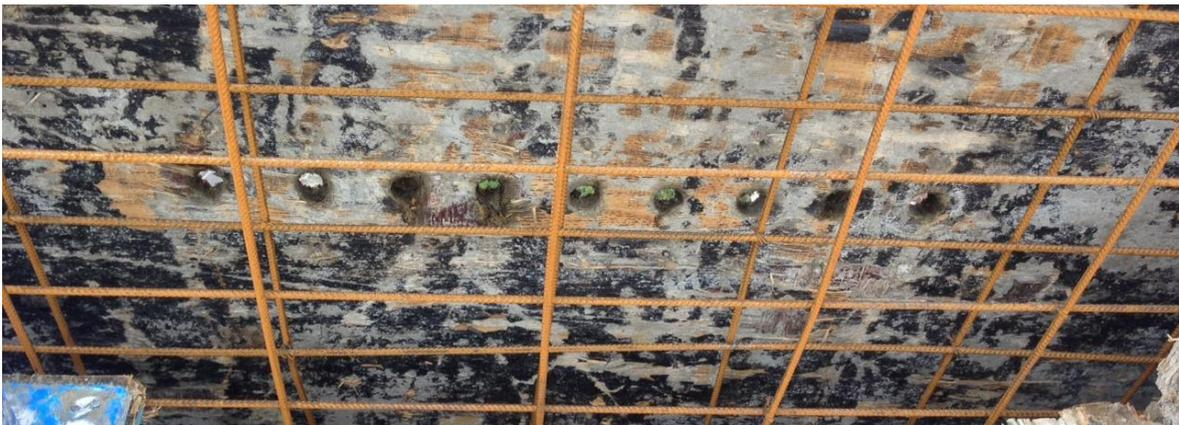
*Figura 24 - Furos onde ficam posicionados a forma para nicho com a placa de ancoragem para passagem da caboalha.*
