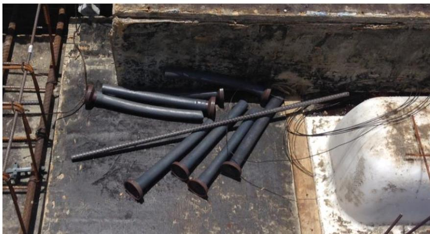
Figura 18 - Barra de aço que servirá para posicionar todos os cabos da seção em uma mesma altura.
