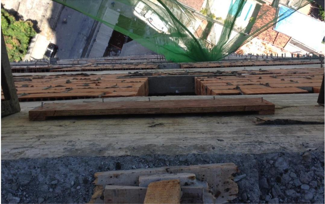
*Figura 31 - Forma na viga de bordo para aplicação do graute e fechamento do nicho.*
