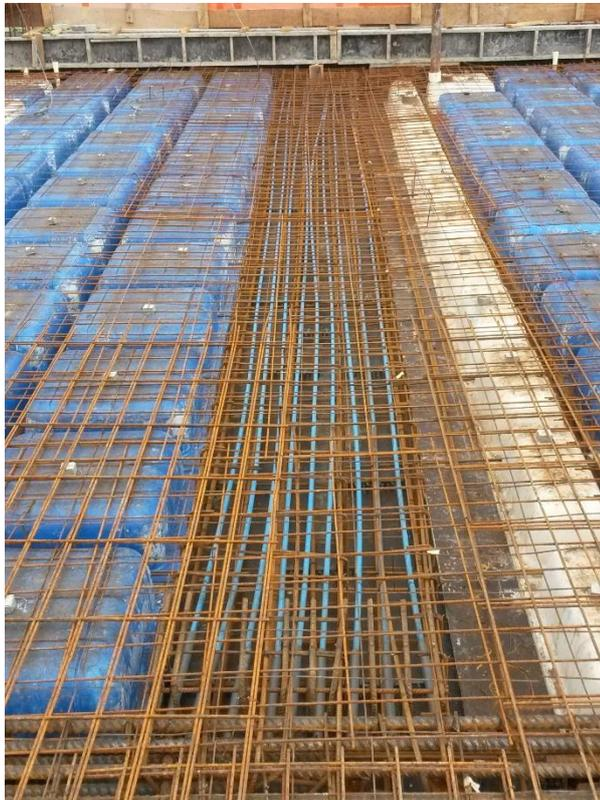
*Figura 8 - Monocordoalhas posicionadas em uma viga que será concretada e, posteriormente, protendida.*
