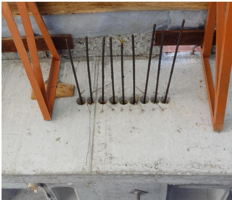
*Figura 16 - Cordoalha desencapada onde será acoplado o macaco hidráulico.*
