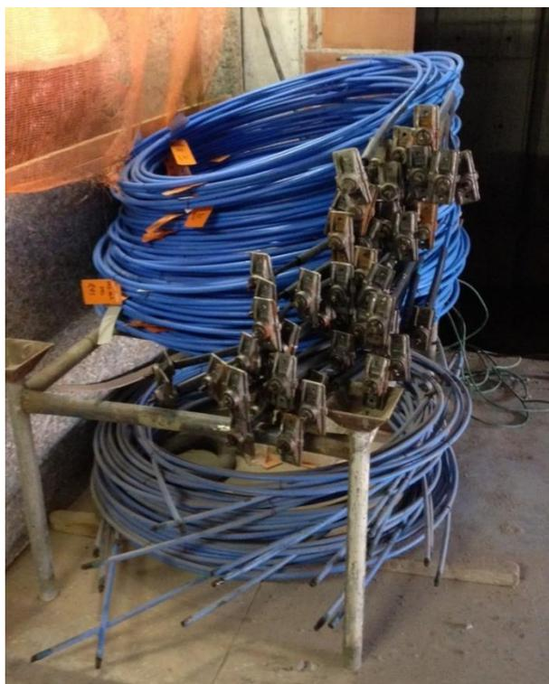
*Figura 15 - Exemplo de boa estocagem das monocordoalhas.*
