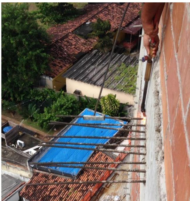
*Figura 30 - Corte do cabo excedente com maçarico, e utilização de equipamento para que a ponta do cabo não caia de uma grande altura.*
