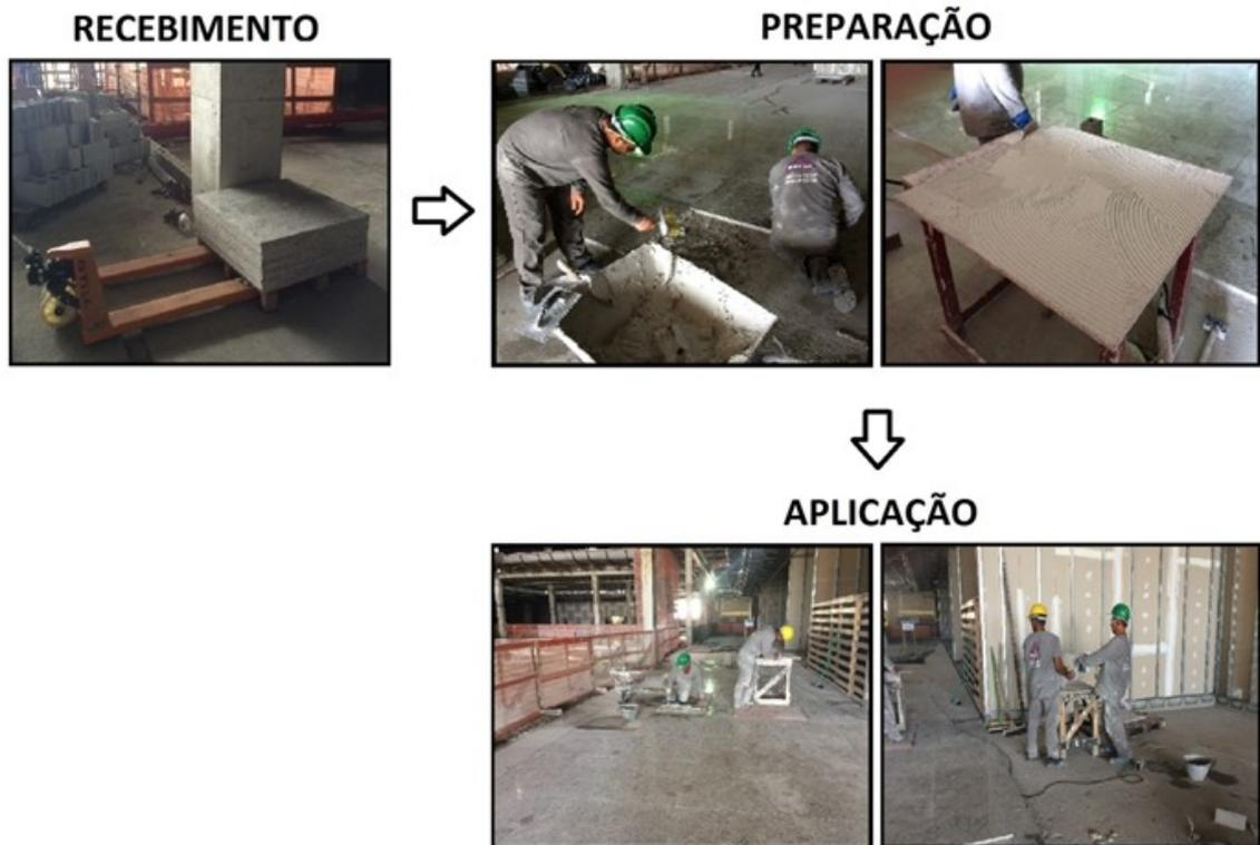
Figura 26 - Recebimento, preparação e aplicação das pedras no local de aplicação.
