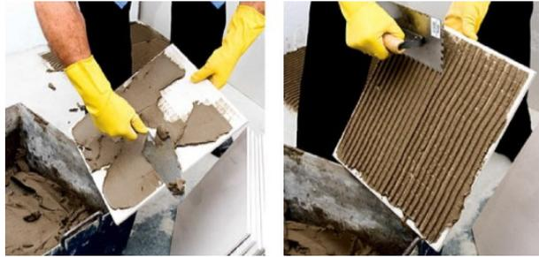
Figura 11 - Aplicação da argamassa colante no verso da peça.
