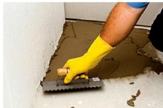
Figura 9 - Camada uniforme de argamassa.
