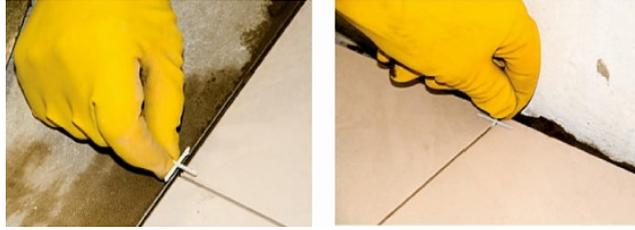
Figura 13 - Aplicação de espaçadores para espera do rejuntamento.
