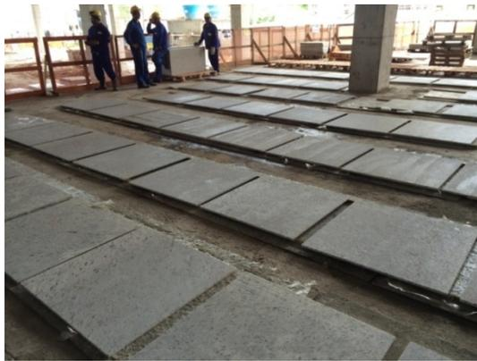
Figura 18 - Pedras espalhadas para que seque o impermeabilizante.
