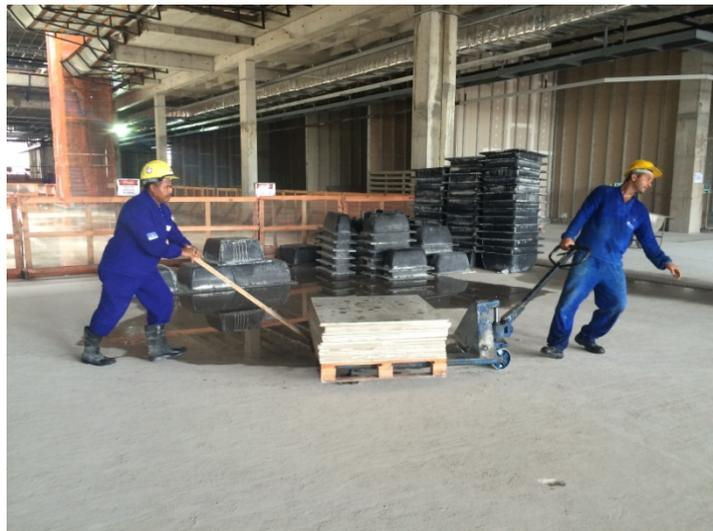
Figura 20 - Transporte das pedras de granito para o local de aplicação.
