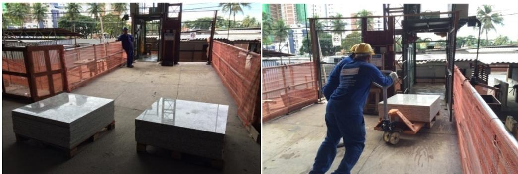
Figura 23 - Transporte vertical das pedras de granito.
