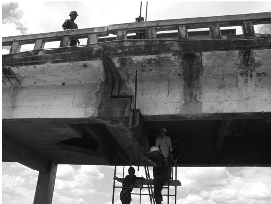
Figura 1.4 – Troca de aparelho de apoio danificado por infiltração na junta – Ponte sobre o Rio Paraíba – Itabaiana / PB (Foto Mauricio Pinho)
