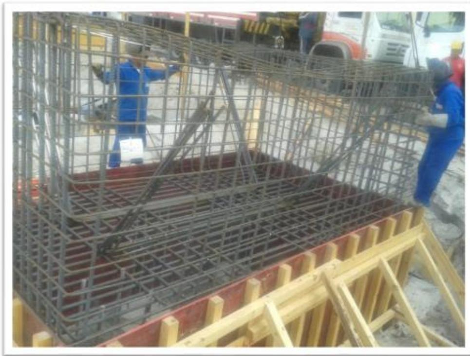
Figura 18. (Posicionamento de uma armadura montada de bloco de fundação/ Empreendimento da Construtora CETA, Recife, 2015)
