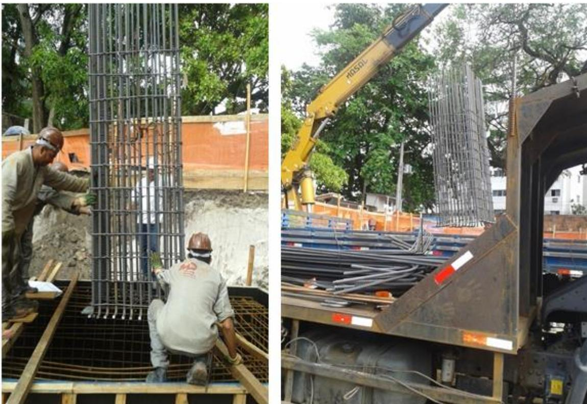
Figura 15. (Transporte e montagem de bloco de fundação e pilar de arranque/ Foto tirada em uma obra da Incorporadora Moura Dubeux S/A, em parceria com a Aço Pronto Nordeste, Recife, 2015).
