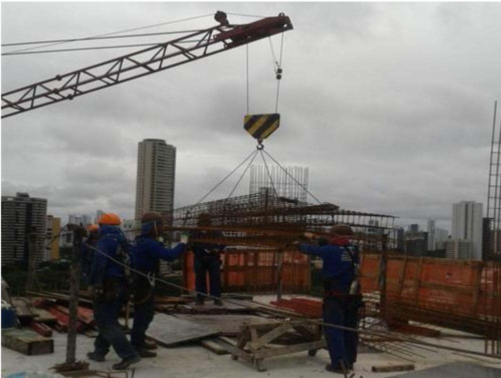
Figura 21. (Içamento de pilares pré-montados pela grua da obra/ Empreendimento da Construtora CETA, Recife, 2014).
