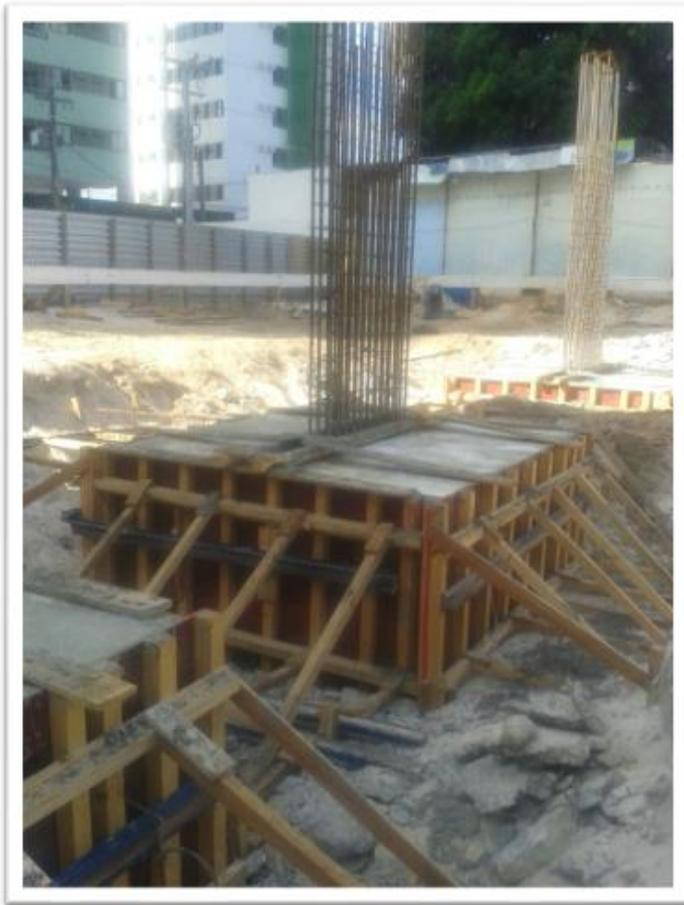
Figura 20. (Bloco de fundação concretado/ Empreendimento da Construtora CETA, Recife, 2015).
