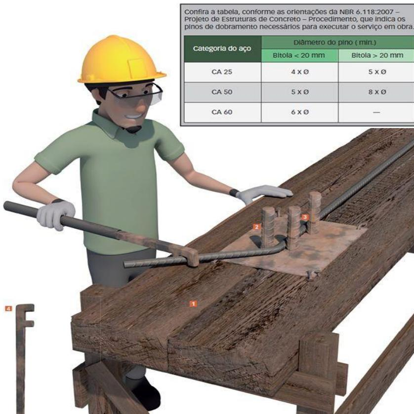
Figura 10. (Processo manual de dobra do aço/ Imagem retirada da Apresentação de Corte e Dobra, Gerdau Armafer).
