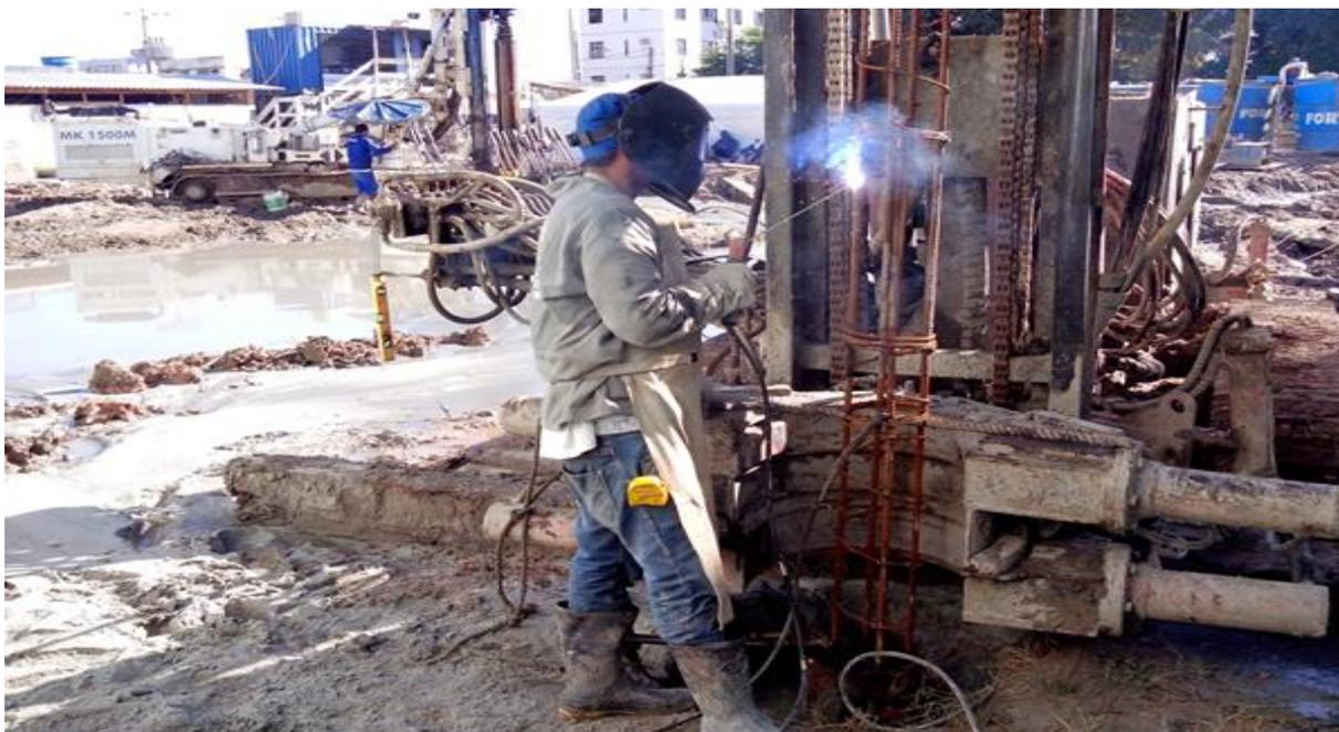
Figura 14. (Emenda de partes das estacas na obra com mão de obra da Indústria/ Foto tirada do empreendimento da construtora BFC, Recife, 2015).
