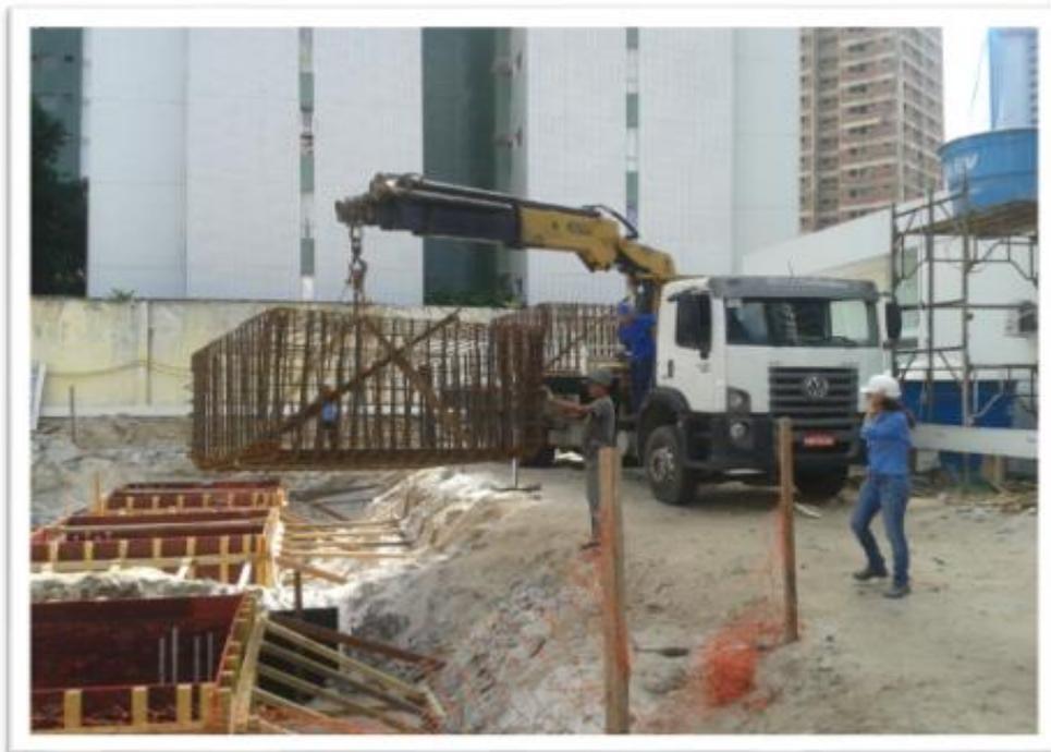
Figura 19. (Movimentação da armadura de um bloco de fundação com ajuda do caminhão Munk fornecida pela indústria de pré-montagem/ Empreendimento da Construtora CETA, Recife, 2015).
