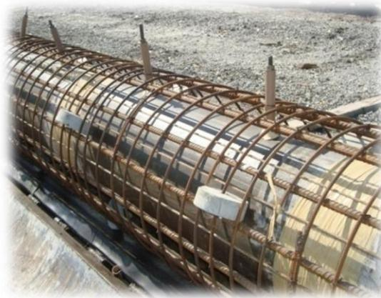
*Foto 3.8. Estacas com os espaçadores.*
