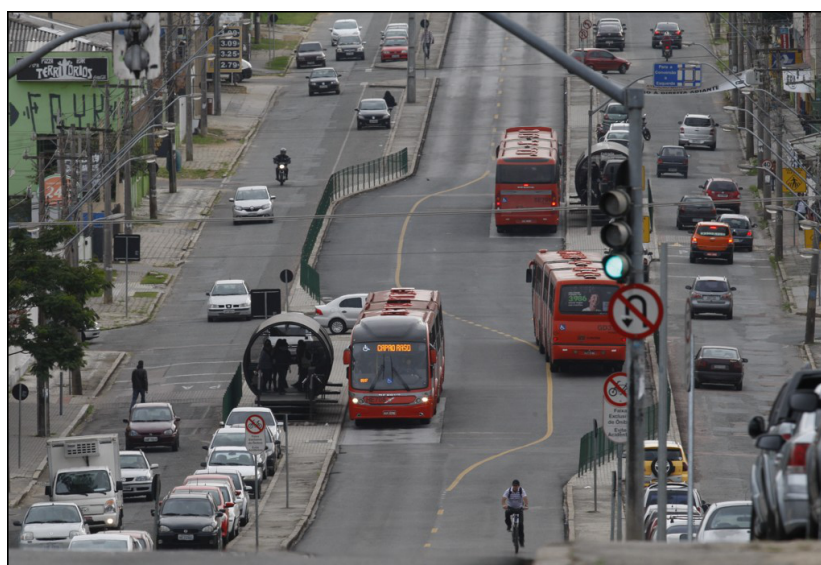
Figura 14: O corredor eixo Norte - Sul em Curitiba possibilita ultrapassagem
