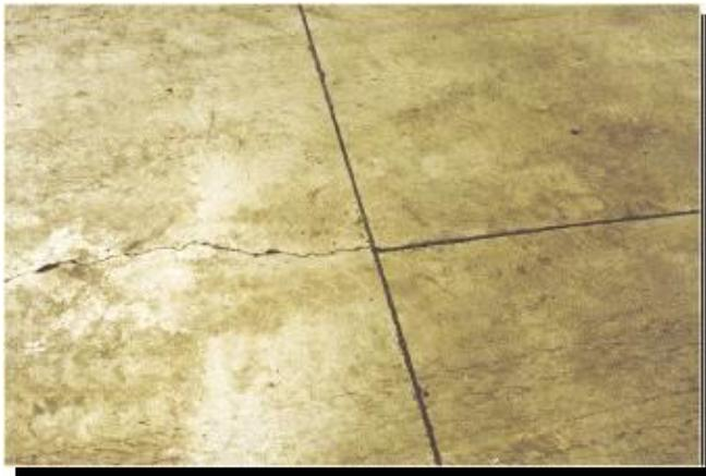
**Fig. 2.20** – Junta de construção terminando em junta serrada gerando uma trinca alinhada com a junta de construção (fonte: [www.lmbrasil.com.br](http://www.lmbrasil.com.br)).
