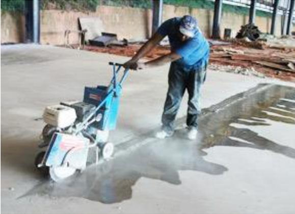
**Fig. 2.14** – Corte para execução da junta serrada (fonte: blogdopetcivil.com).
