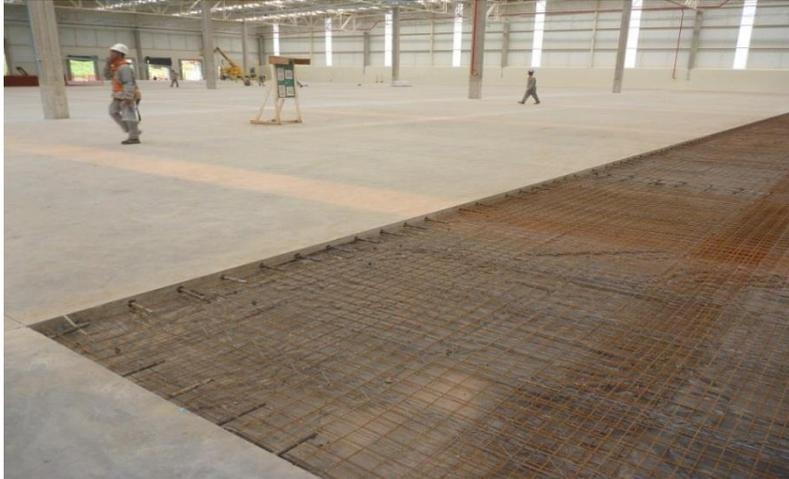
**Fig. 2.15** – Juntas de construção com o uso de barras de transferência (fonte: [www.rhinopisos.com.br](http://www.rhinopisos.com.br)).
