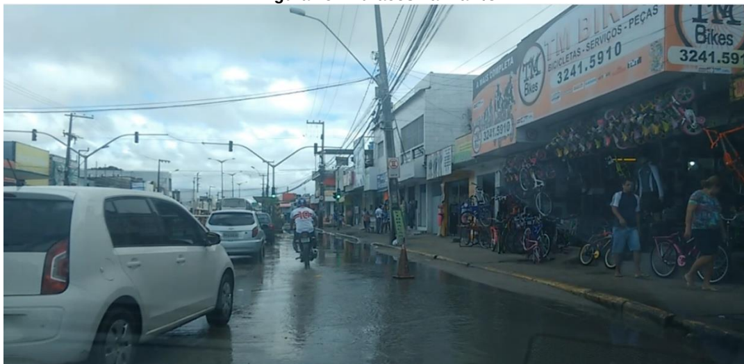
Figura 15 - Buracos na Via 1/3
