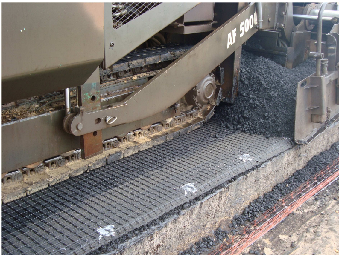
Figura 14 - Aplicação de geogrelha no trecho da BR-101
