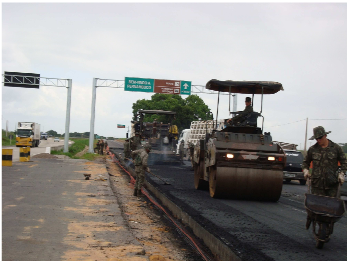
Figura 15 – Aplicação de geogrelha no trecho da BR-101
