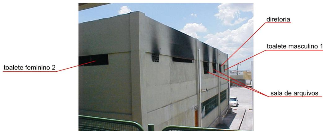
*Figura 4.2 – Visualização externa da edificação atingida pelo incêndio. Fonte: a autora*
