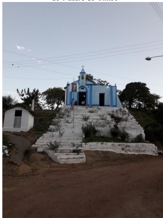
Figura 9 - Imagem da Igreja de Nossa Senhora do Nazaré do Timbó
