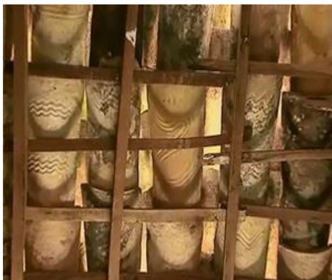
Figura 13 - Telhado da Igreja do Nossa Senhora de Nazaré do Timbó
