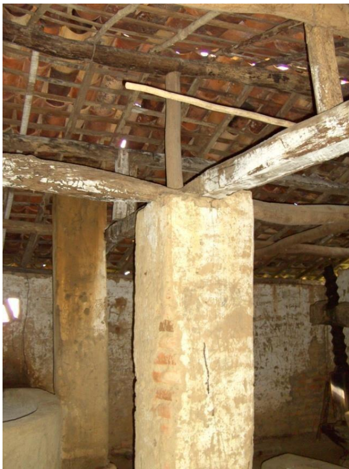
Figura 39 - Telhado de uma casa de farinha
