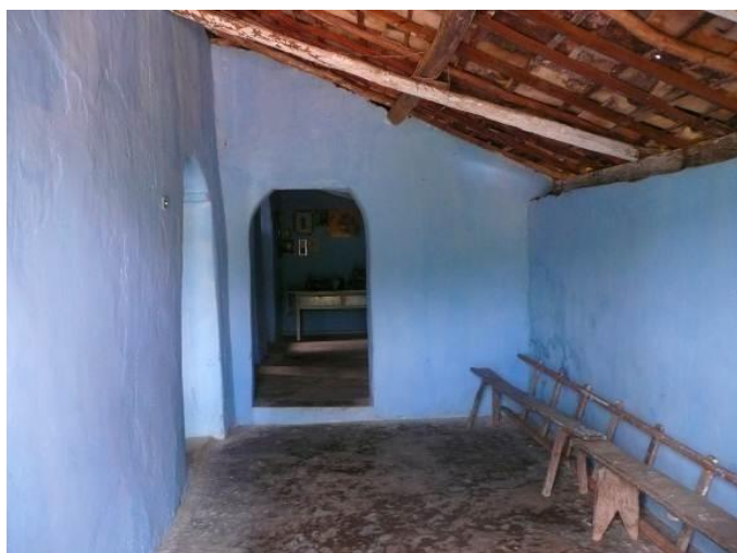
Figura 12 - Nave lateral ou galeria da Igreja
