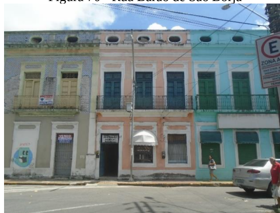
Figura 70 - Rua Barão de São Borja
