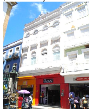
Figura 40 - Imóvel à Rua do Livramento, 110, com eliminação da escada frontal
