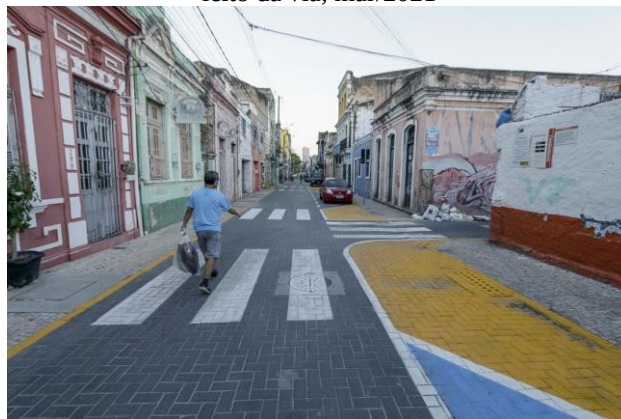
Figura 76 - Rua Velha após intervenção de elevação do leito da via, mar/2021
