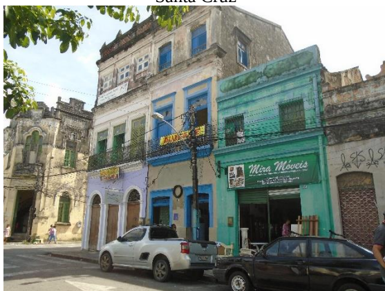
Figura 71 - Imóveis em situação regular, no Pátio de Santa Cruz
