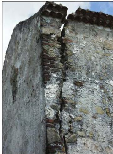
Ilustração 08 – Aproximação do detalhamento da rachadura que ameaça a estrutura da Igreja de São Bento. Foto: Hermínio.
