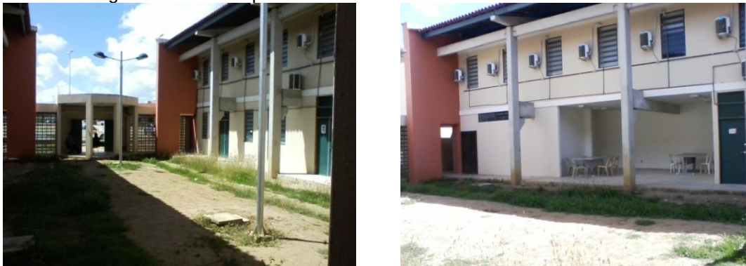
Figura 38: vista do pátio interno da casa do estudante da UFPE/CAA
