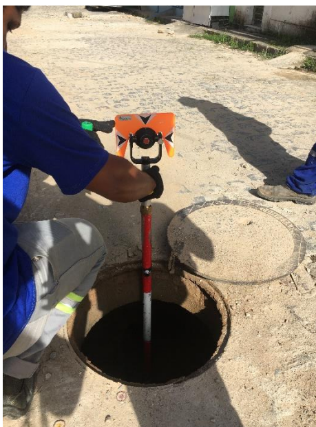
Figura 33: Coleta da Profundidade do Poço de Visita
