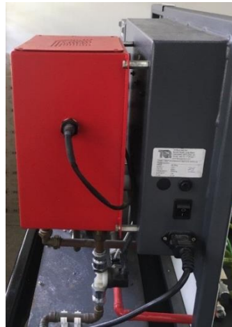
Figura 16 - Tanque de armazenamento
