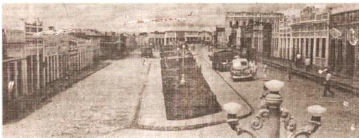
Figura 52 - Rua do Comércio, em 1949, após a reforma do calçamento e a pavimentação da via
