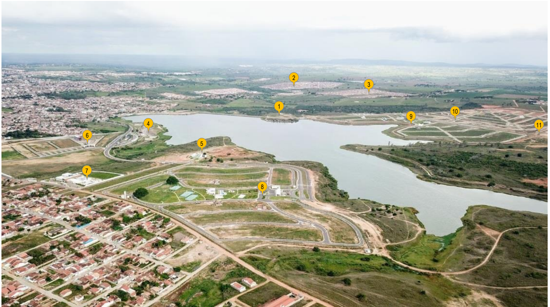
Figura 83 - Vista área do Lago da Perucaba e seu entorno. (1) Vila dos Pescadores; Conjuntos Habitacionais financiados pelo Programa Minha Casa, Minha Vida; (2) Residencial Brisa do Lago e (3) Residencial Vale do Perucaba; (4) Intervenção urbana realizada pela Prefeitura; (5) Planetário e Casa da Ciência; (6) Empresarial Zona Sul (loteamento fechado para uso corporativo); (7) Unimed Metropolitana do Agreste; (8) Residencial (fechado) Riviera do Lago; Perucaba Bairro Planejado: (9) Residencial (fechado) Reserva Perucaba, (10) Residencial (fechado) Jardins Perucaba I e (11) Jardins (fechado) Perucaba II (não registrado na imagem)
