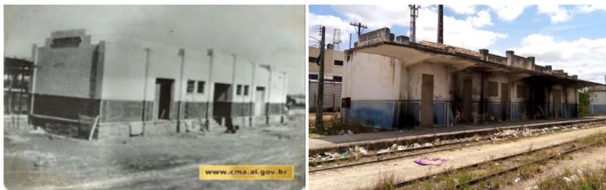
Figura 51 – (A) Estação Ferroviária Arapiraca em construção; (B) o edifício, em 2020.
