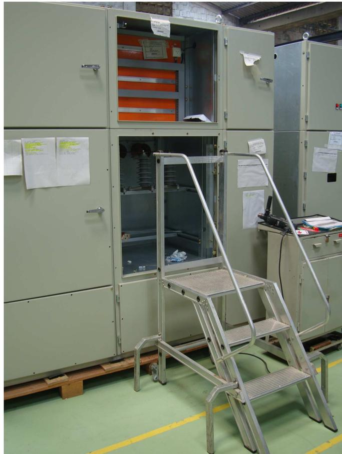
**Figura 3.3 - Berço de comando e força sendo montada no próprio painel com auxílio de escada (Fonte: Autor)**
