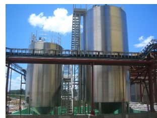
Figura 3.3 – Recepção de ingredientes líquidos Fonte: Empresa estudada (2007)
