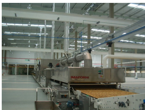
Figura 3.6 - Estrutura externa do forno Fonte: Empresa estudada (2007)
