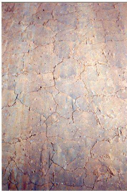
Figura 2.15 – Padrão de trincamento na base de solo fino, trecho experimental 1 observado por Rezende (2003).
