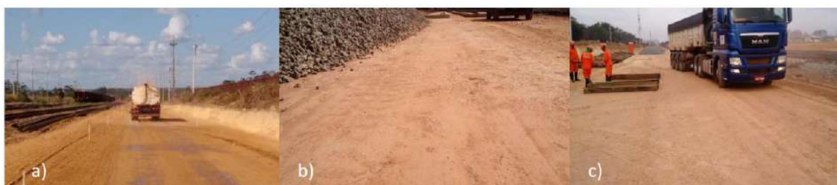
Figura 2.14 – a) Umedecção da plataforma para selagem; b) trincas seladas e c) liberação do tráfego.
