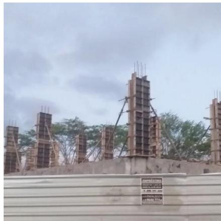
Figura 02 – Caixa para coluna
