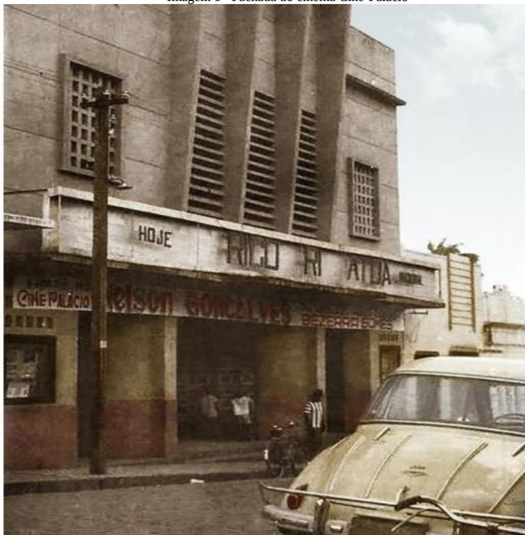
Imagem 1 - Fachada do cinema Cine-Palácio
