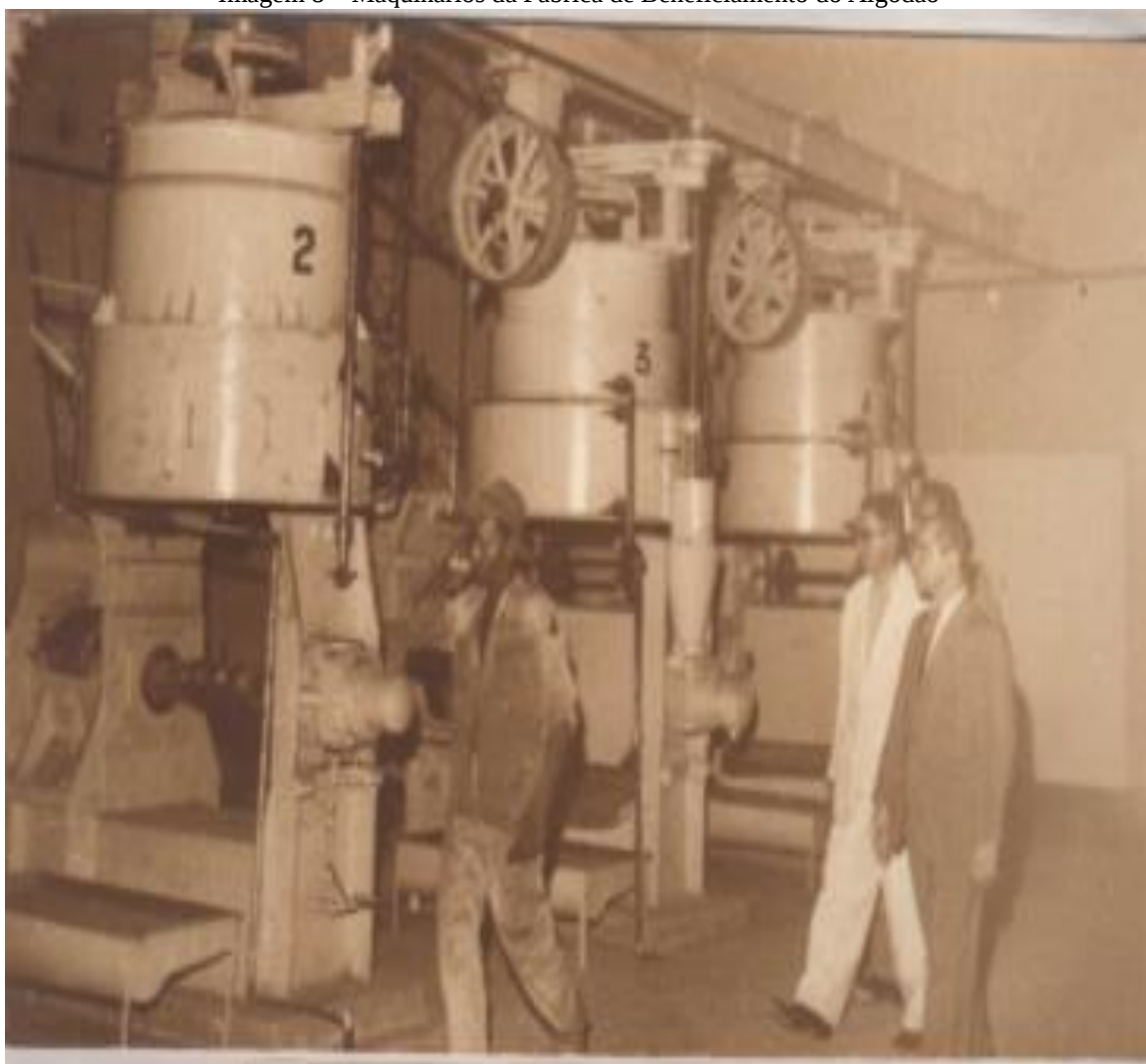
Imagem 8 – Maquinários da Fábrica de Beneficiamento do Algodão
