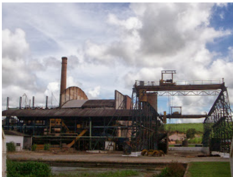
Figura 11 – Ruínas da Usina Bulhões 156
