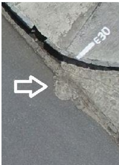
Figura 29 - Panela (Observada a partir do drone)
