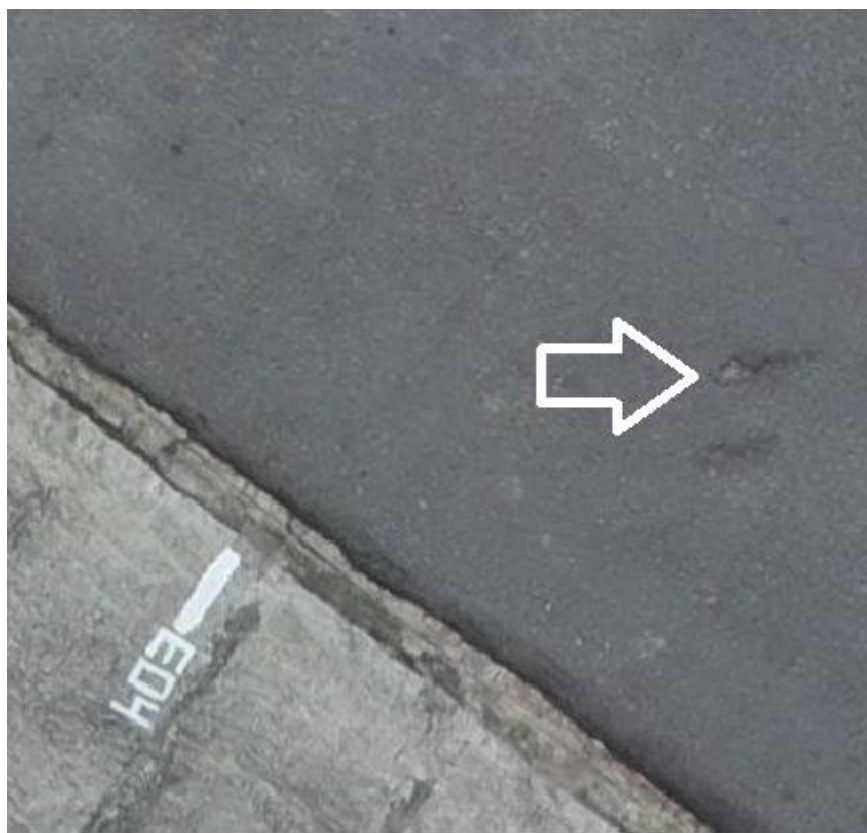
Figura 30 - Desgaste (Observado a partir do drone)
