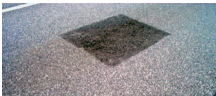
Figura 4 - Remendo
