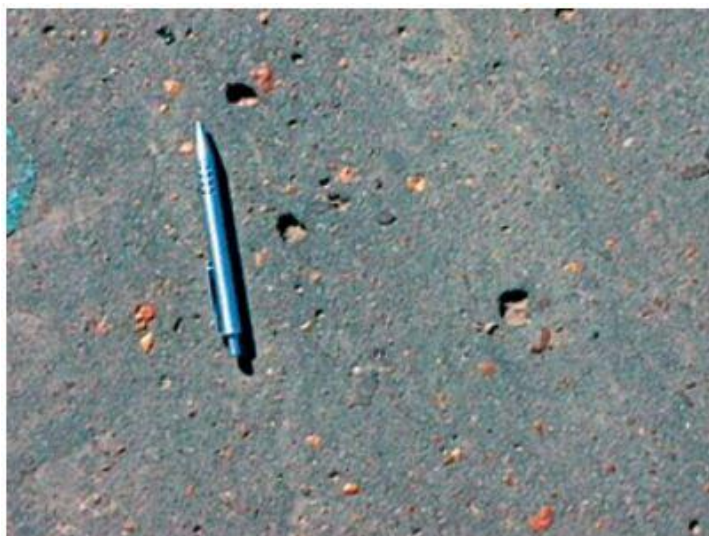
Figura 3 - Desgaste
