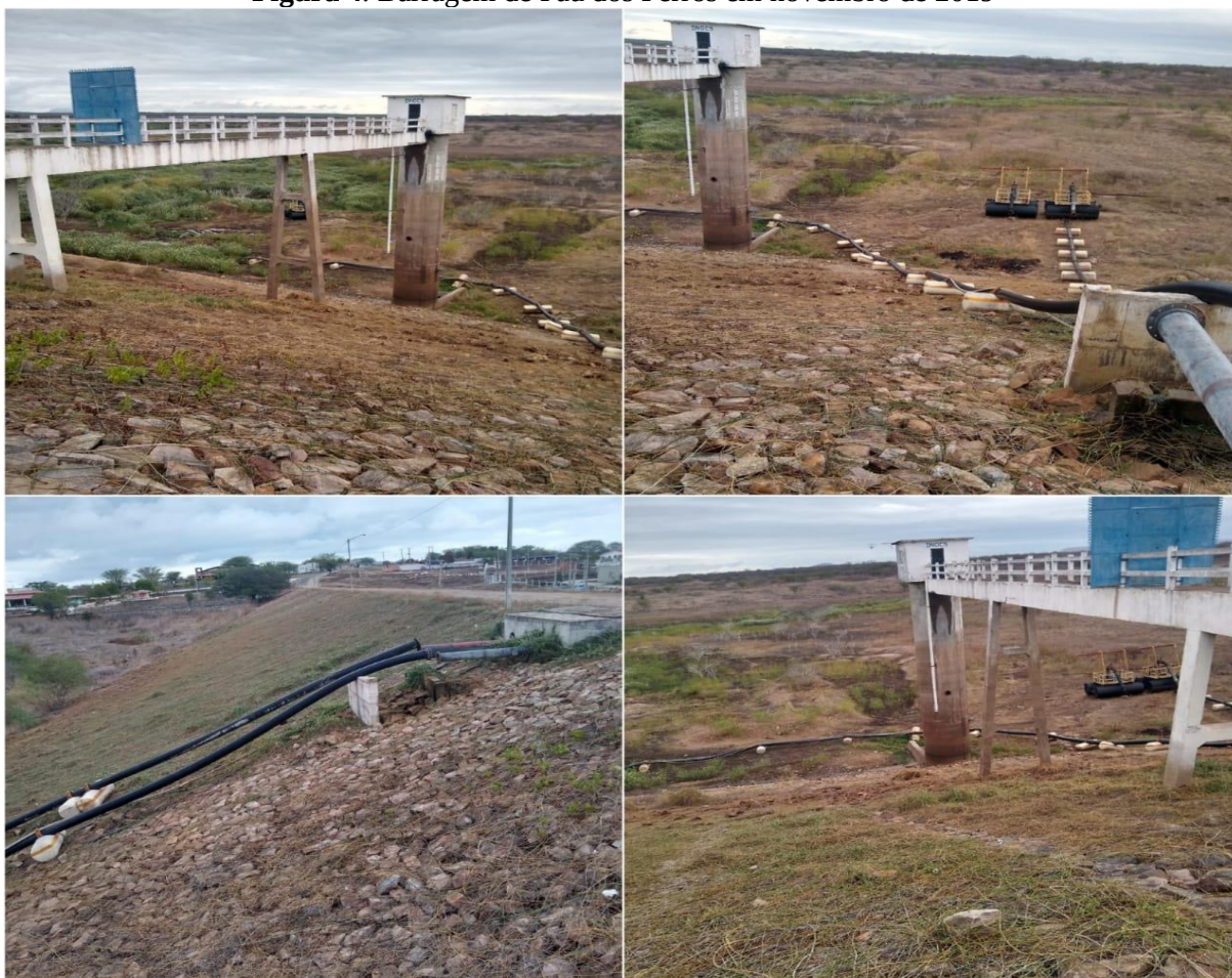
Figura 4: Barragem de Pau dos Ferros em novembro de 2019
