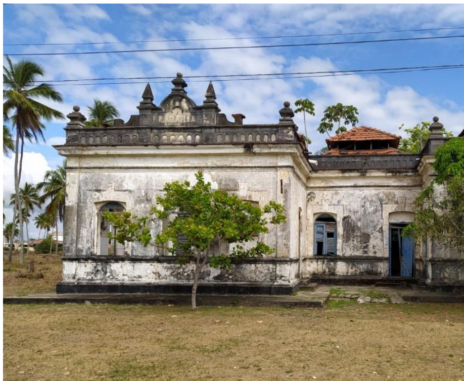
Figura 8: Prédio da padaria da Escola de Pesca de Tamandaré atualmente, sem funcionamento
