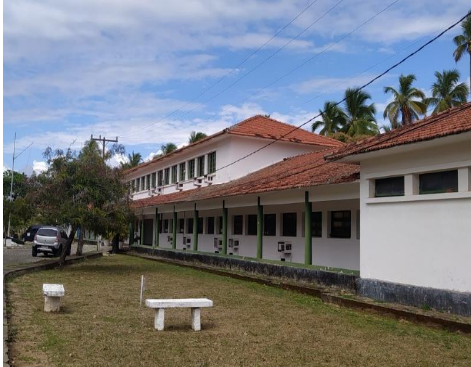
Figura 6: Prédio administrativo atualmente, que mantém seu caráter administrativo para o Centro de Pesquisa e Conservação do Nordeste
