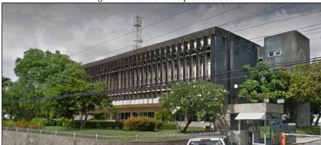
Figura 4 – Vista frontal do prédio do COS
