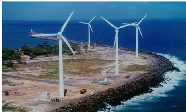
**Figura 3** – Turbinas de Eixo Horizontal com três pás
