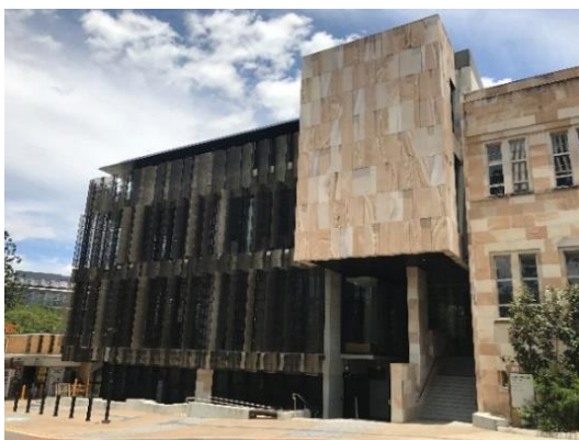
Figura 9 - Painéis pré-moldados de concreto geopolimérico
