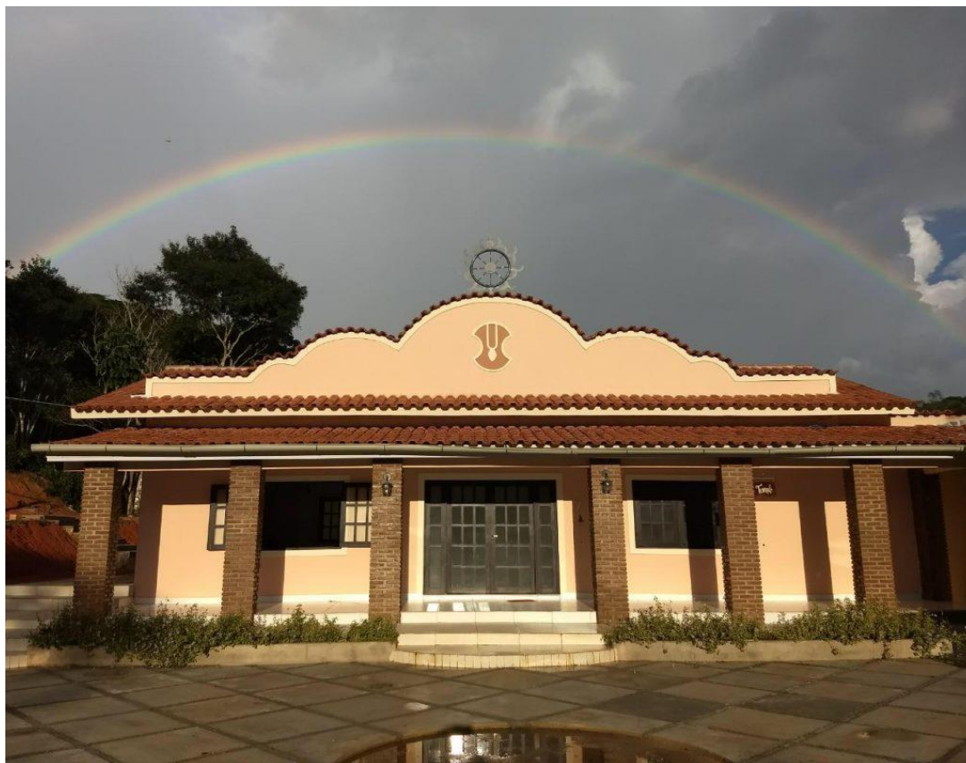
Fotografia 3 – Templo da Ecovila Vraja Dhama
