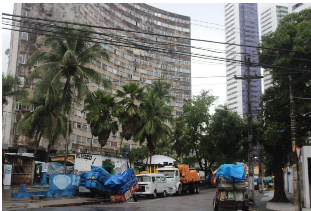
Fotografia 2 - Edifício Holiday - Rua Salgueiro
