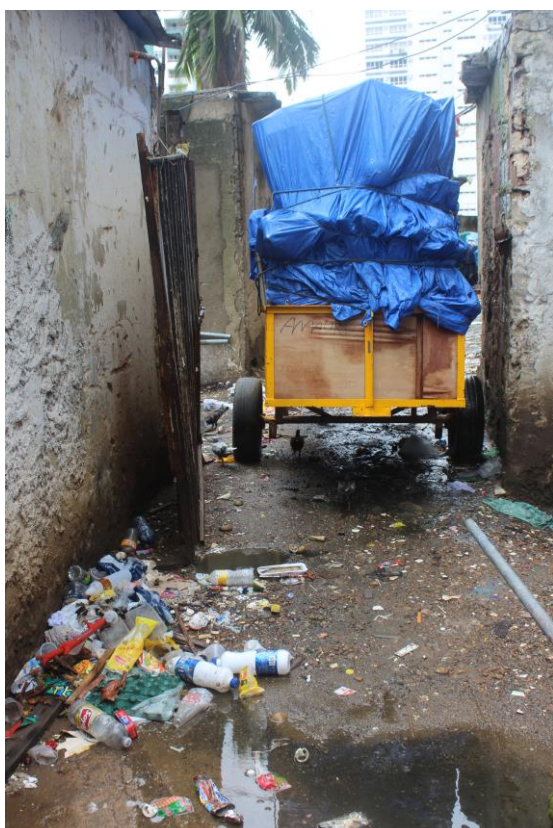
Fotografia 8 - Edifício Holiday - Sujeira - 2
