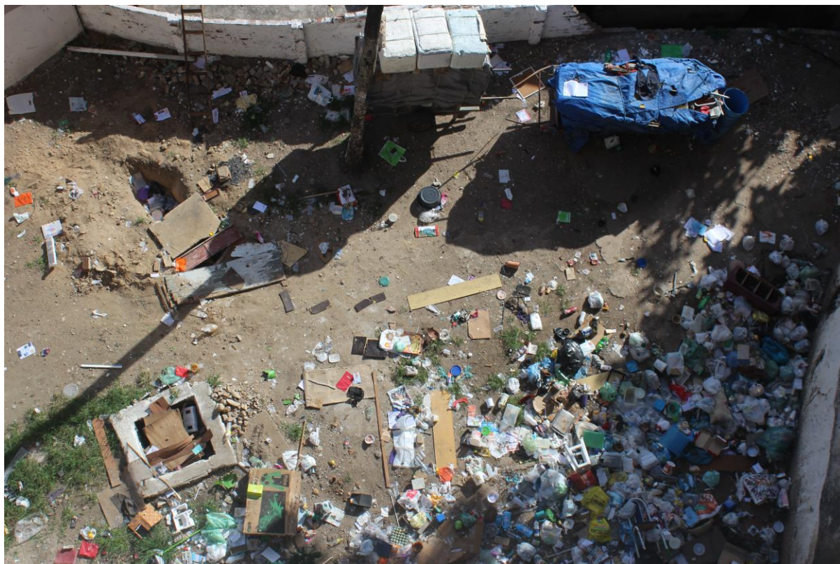
Fotografia 10 - Edifício Holiday - Sujeira - 4
