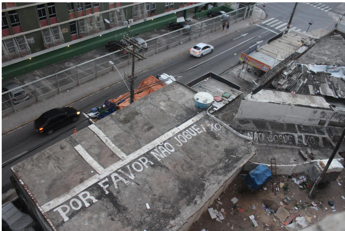
Fotografia 9 - Edifício Holiday - sujeira - 3
