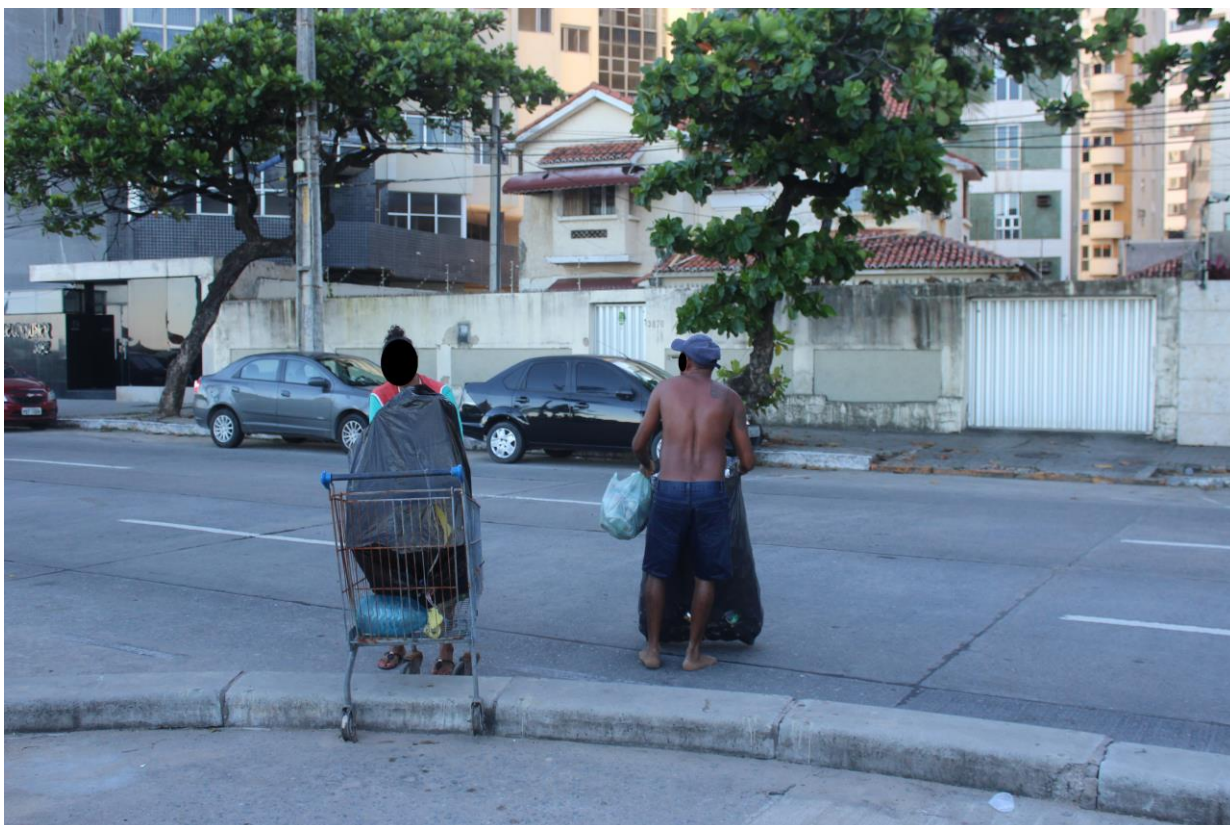
Fotografia 46 - Desmontagem de bar - 2
