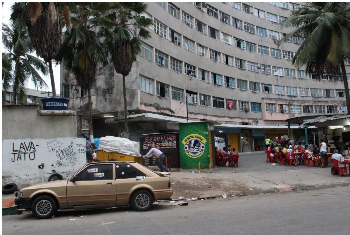
Fotografia 3 - Edifício Holiday - Entrada para o depósito de carroças
