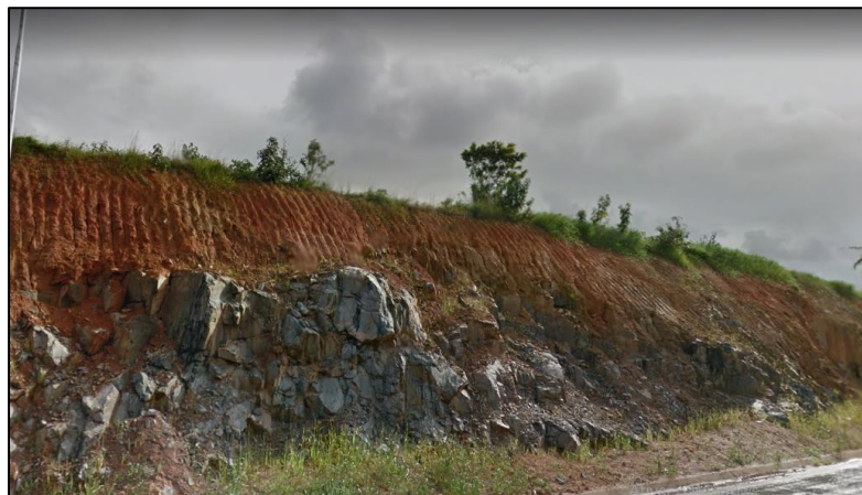
Figura 10: Afloramento rochoso do embasamento cristalino em um talude de corte.
