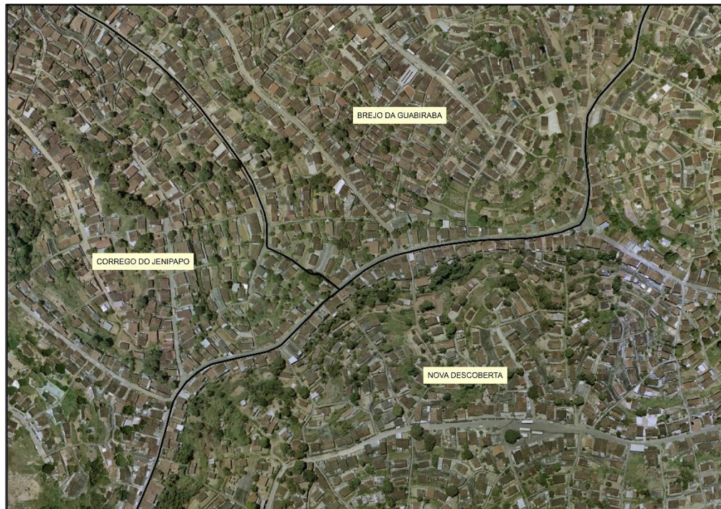
Figura 31 - Imagem aérea de bairros da zona norte atingidos por escorregamentos, sendo possível observar a elevada densidade de moradias.
