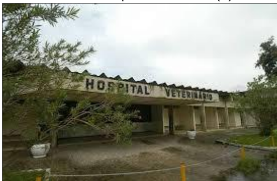
Foto 1 - Hospital Veterinário (A)
