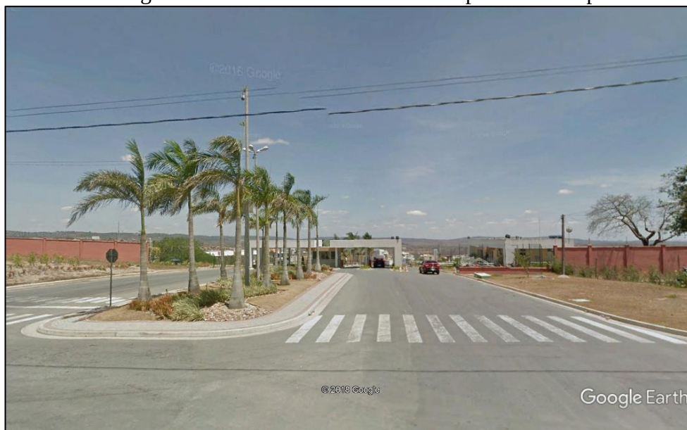
Figura 07: Entrada do Condomínio Alphaville Campina Grande
