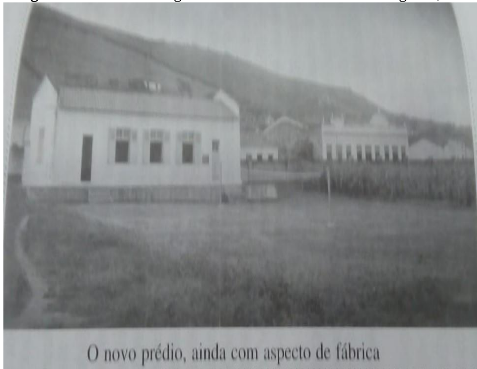
Imagem 12- Prédio da antiga Fábrica de Beneficiamento de Algodão, década de 1940.
