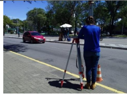
Figura 18d: Mira na Ré sobre a RN PRCP e a segunda estação de nivelamento. Foto: 16 de julho de 2018.
