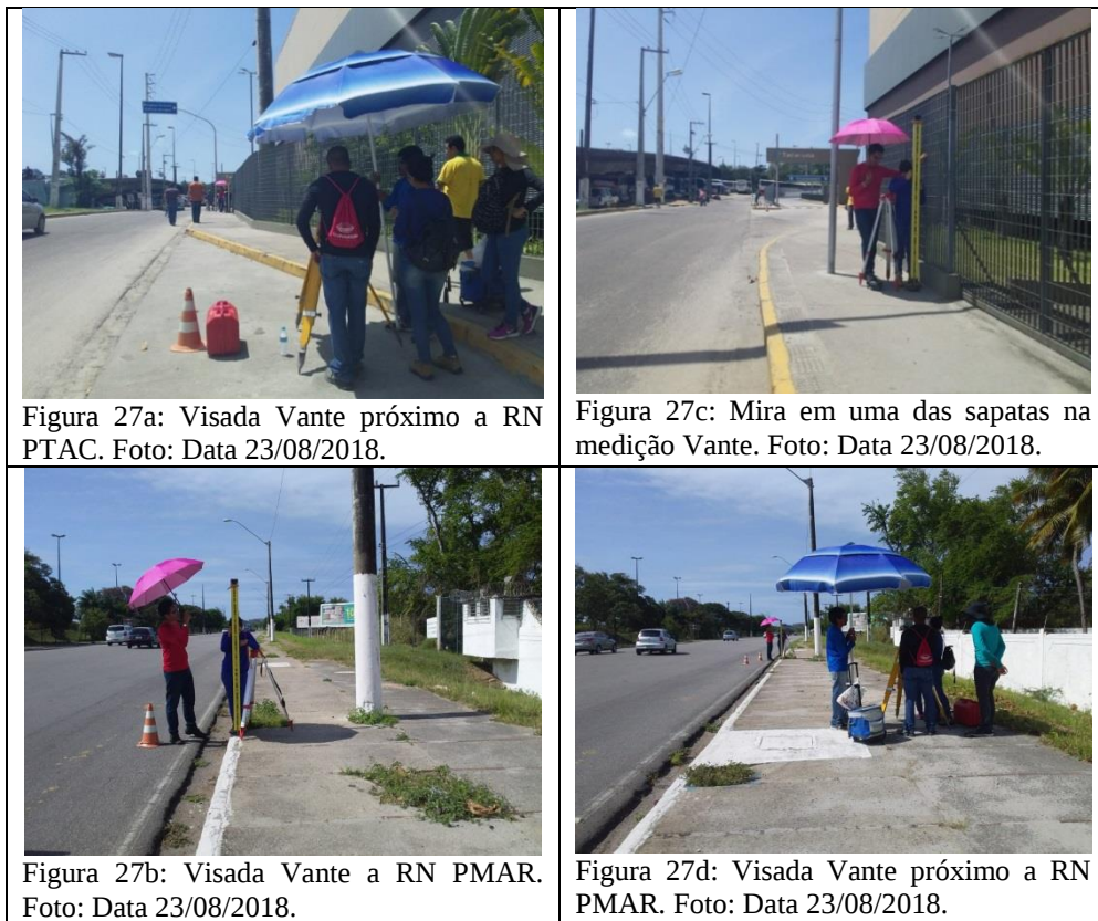
Figura 27 - Visada entre as RRNN: PMAR e PTAC.
