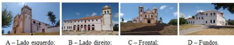
Figura 7 - Vista das fachadas da Igreja Nossa Senhora do Carmo.
