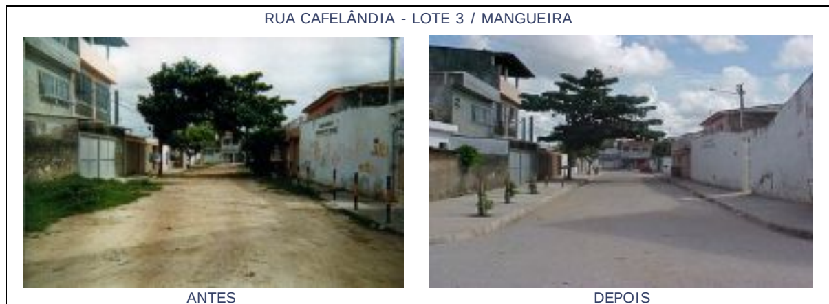
Figura 11- Obras realizadas Mangueira
