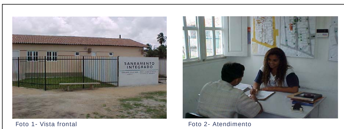
Figura 12- Escritório de Saneamento Integrado
