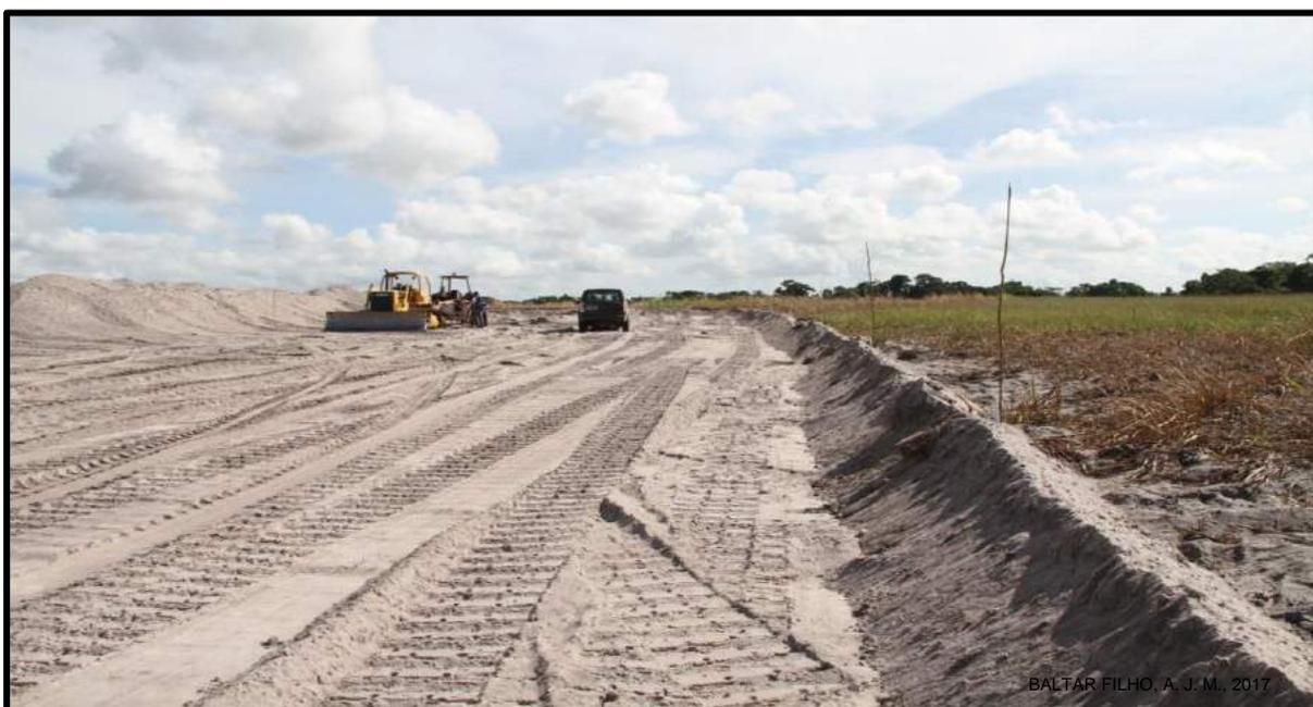
Figura 53 - Etapa de remoção de capeamento
