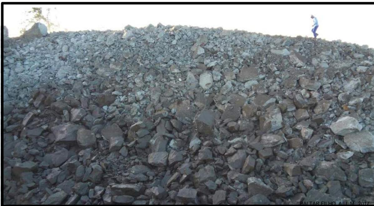
Figura 63 – Material fragmentado após desmonte com explosivos
