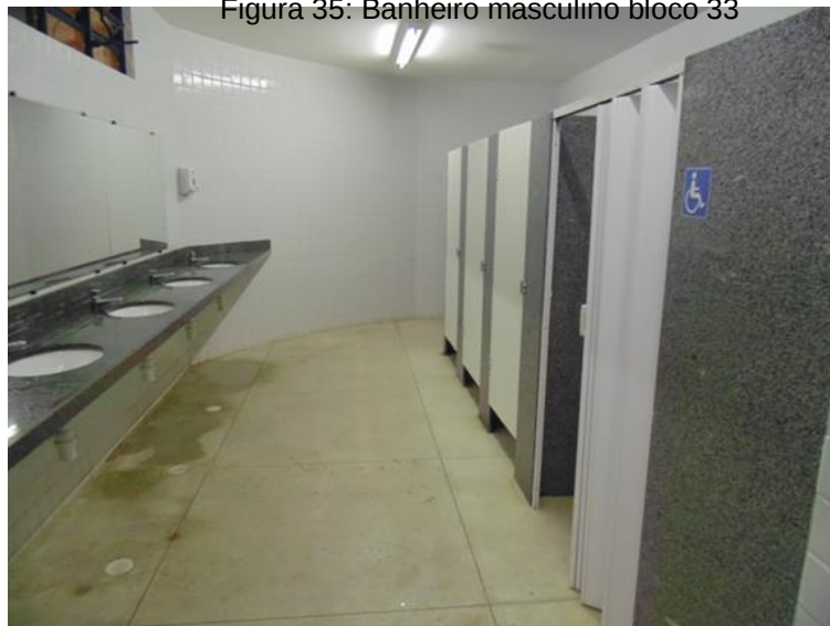
Figura 35: Banheiro masculino bloco 33
