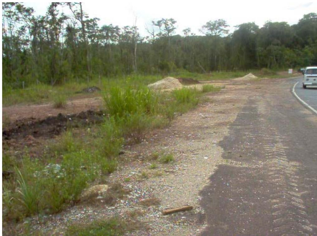
Foto 4. Berma de equilíbrio deteriorada por precipitação pluviométrica
