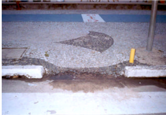
Fotografia 14 – Rampa na Faixa de Travessia
