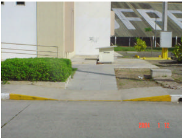
Fotografia 27 – Edificação de Terapia Ocupacional
