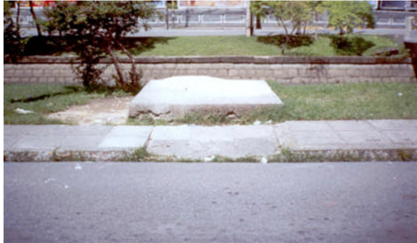
Fotografia 11 – Rampa com Barreira
