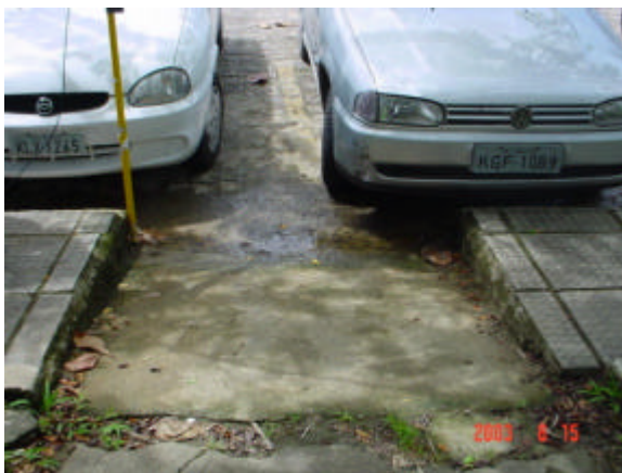
Fotografia 25 – Prédio do Antigo RU
