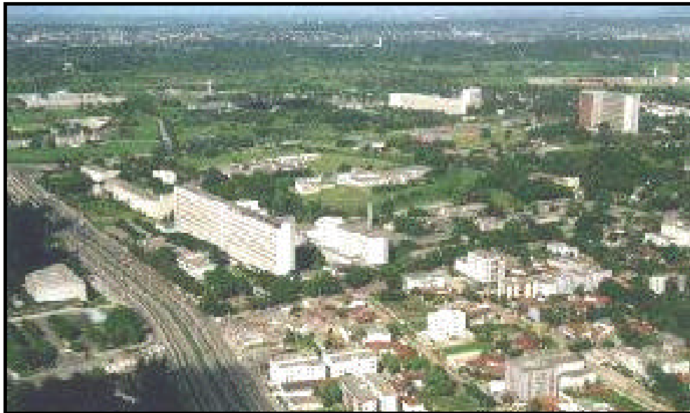
Fotografia 24 – Vista Aérea do Campus
