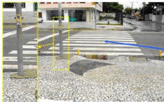
Fotografia 13 - Rampas na Faixa de Travessia. No detalhe o botão que aciona o Semáforo a altura do Cadeirante
