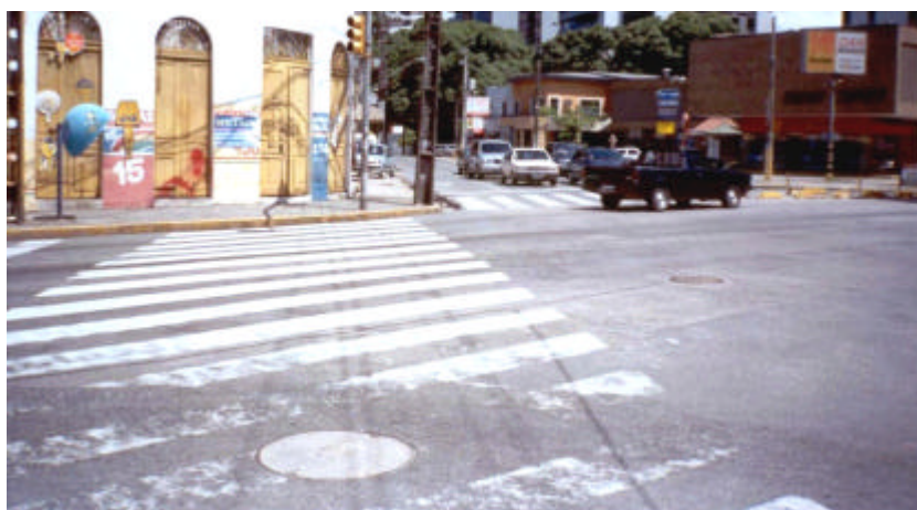
Fotografia 6 – Faixa de Travessia sem uso possível por Cadeirantes
